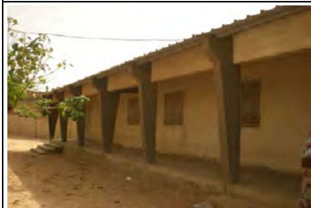
WBの支援で建設された教室棟 （ダカール州 ダルー ミセット小学校）
