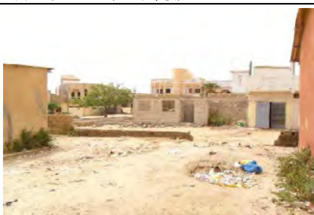
囲い塀が部分的にないため部外者が敷地内に入ってくる。(DK20M ダカール州 キャン マルシャン中学校)
