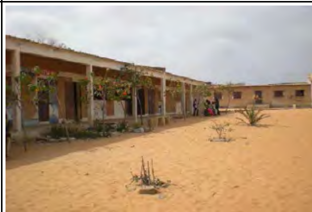
イスラム開発銀行の支援で建設された教室棟 （DK12M ダカール州 バンクイスラミック中学校）
