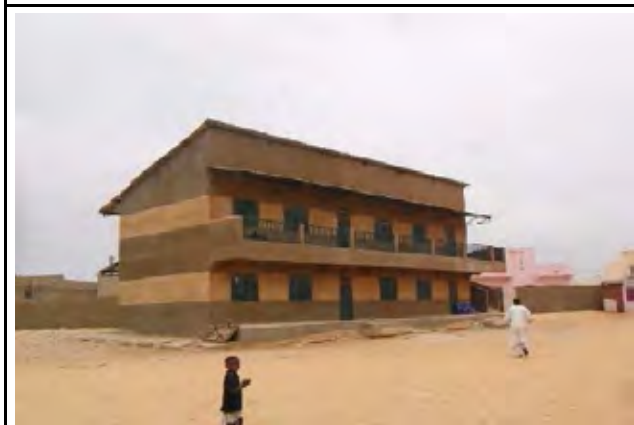
AFDの支援で建設された教室棟 （DK27 ダカール州 カストル ソトラック小学校）
