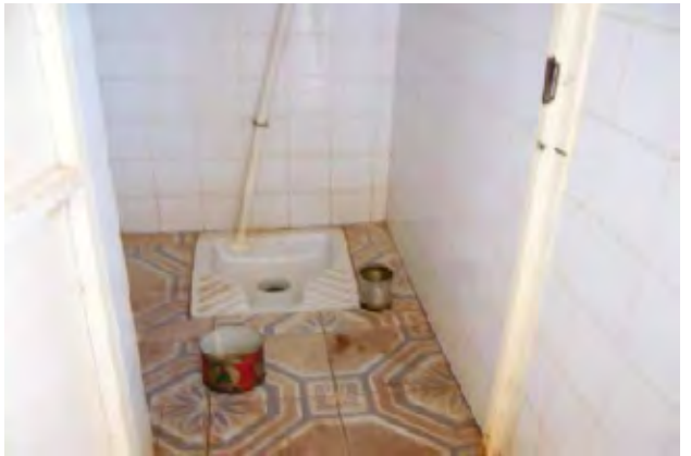
トイレ内部。きれいに掃除されている。（TH15 ティ エス州 スッド スタッド小学校）
