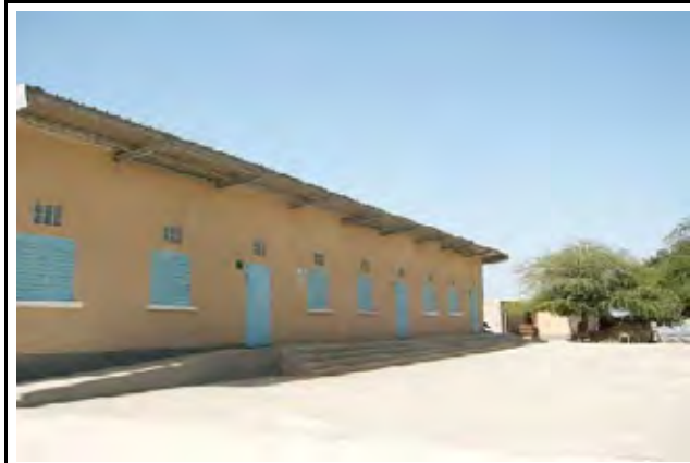
先行するコミ開（第5次）で建設された教室棟 （ダカール州 EFI附属校小学校abc）
