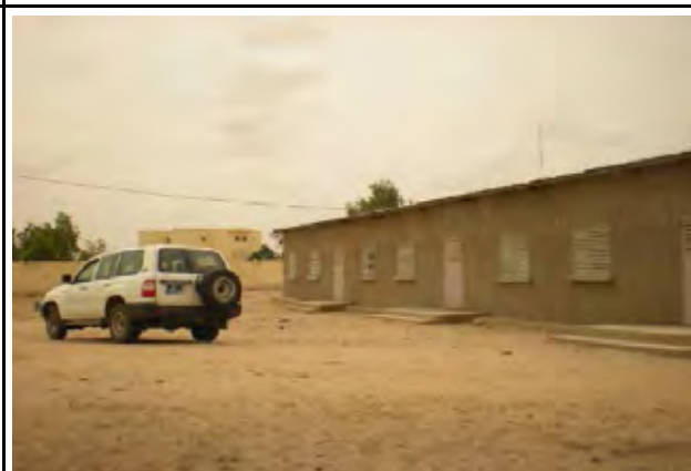
政府の統合投資予算（BCI）で建設された教室棟 （TH19 ティエス州 ティバウアン 13小学校）
