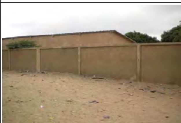
敷地の囲い塀。(TH16M ティエス州 ダロー サラム 中学校)
