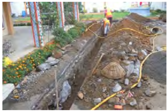
注意深い管設置 (良い例)
