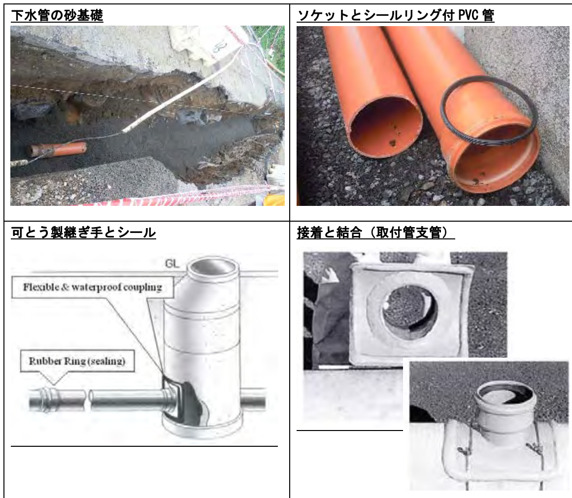
図 5.3-4 建設段階の不明水削減対策 (1/2)
