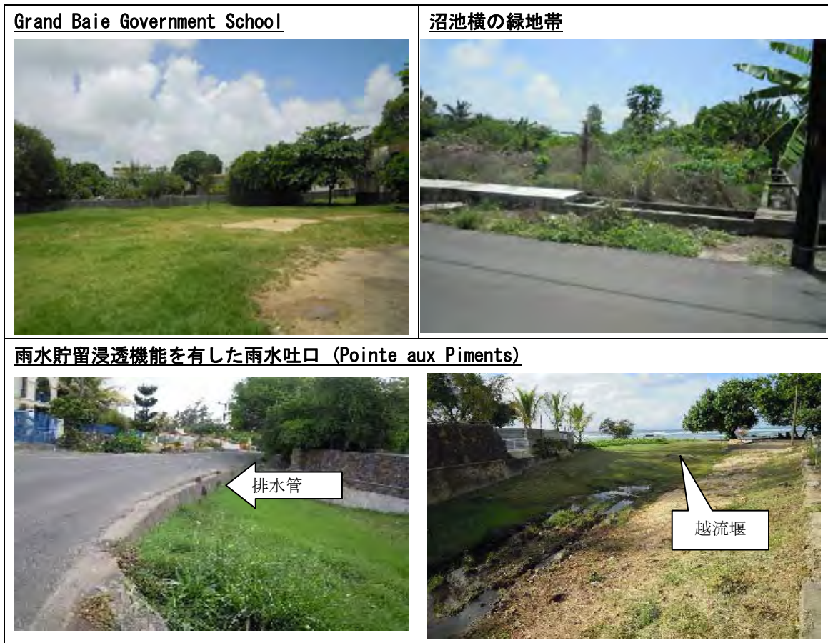
図 5.3-3 雨水貯留施設
