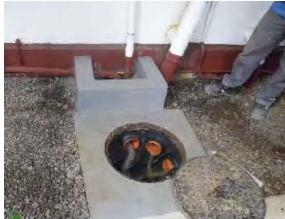
雨水が浸入しない宅地ます (PVC)
