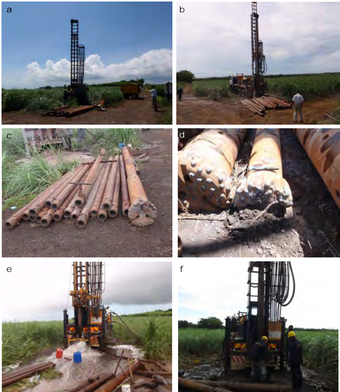
図 4.3-2 (a) ダウンザホールハンマーによる BH-4 孔掘削; (b) ダウンザホールハンマーによる BH-5 孔掘削; (c) ダウンザホールハンマービット及びピロッド; (f) ビットの直径 300mm; (e) BH-4 送水掘削; (f) BH-5 掘進中.
