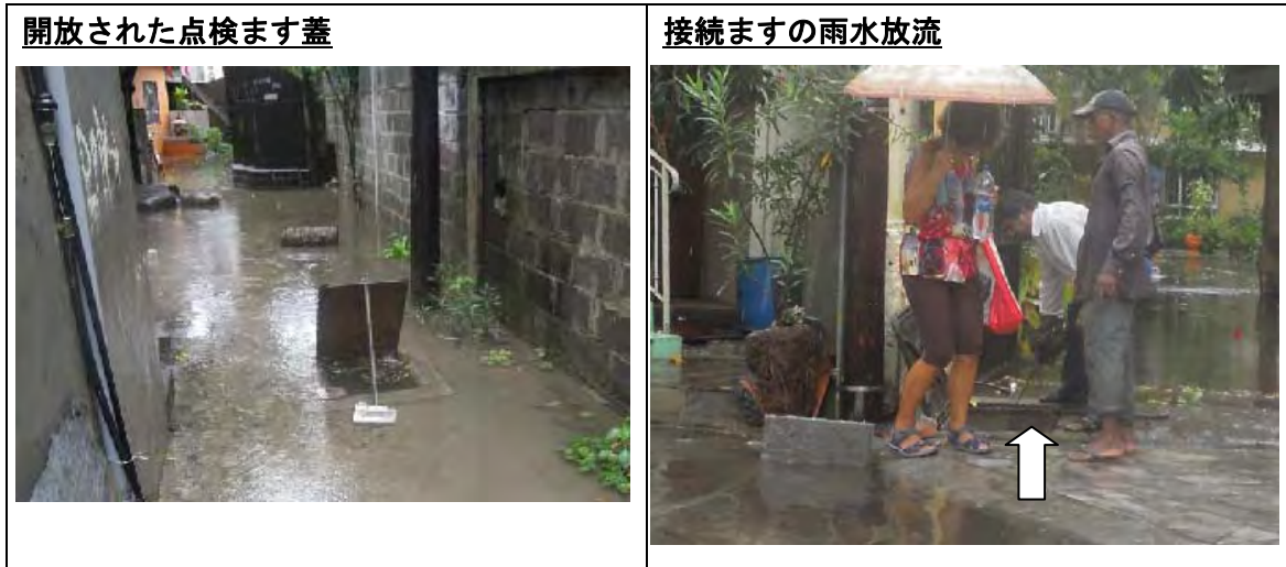
図 S-12 雨天時の道路冠水および不明水（雨天時浸入水）（2/2）
