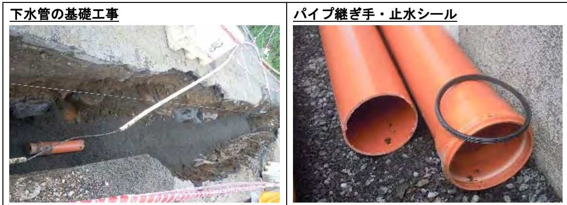
図 S-11 下水管の建設工事
