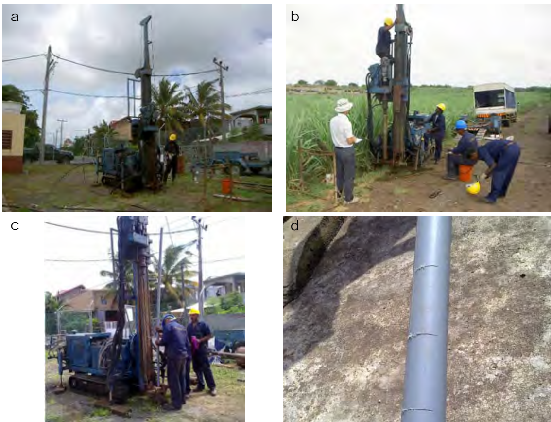
図 4.2-2 (a) ロータリー式ボーリングマシンによる削孔(b) 標準貫入試験; (c) 地下水位観測管の設置; (d) 観測管に設けられたスリット
