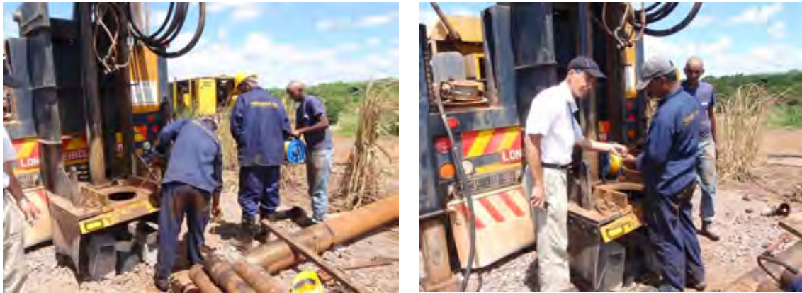
図 4.3-5 地下水位の観測
