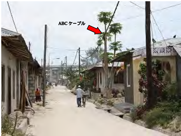
ABC ケーブル敷設状況(ペンバ島)
