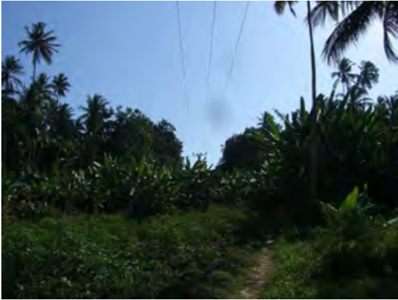
南ルート配電線
