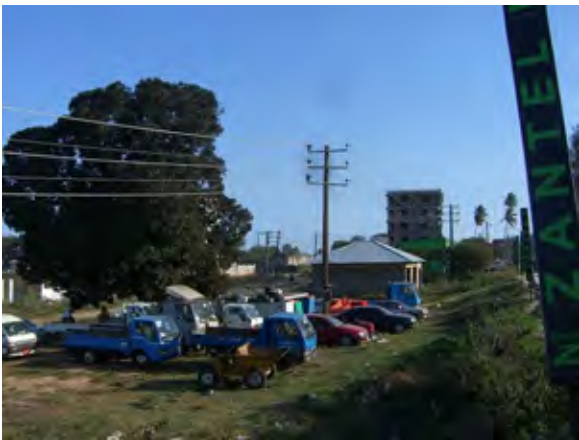
33 kV 配電線ルート(住宅密集地)
