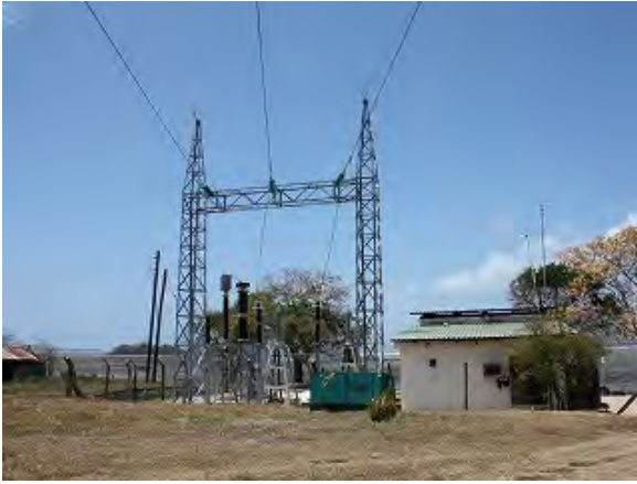
海底ケーブル接合部(Fumba 揚陸地点)
