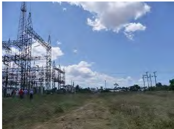
Mtoni 変電所 33 kV 変電設備の建設予定地
