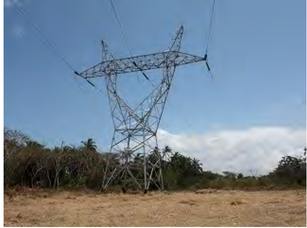
既設 132 kV 送電線
