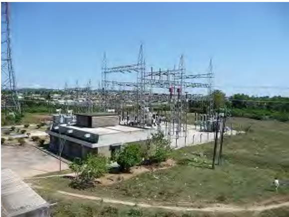
Mtoni 変電所外観
