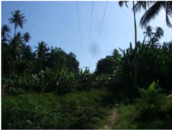
南ルート配電線
