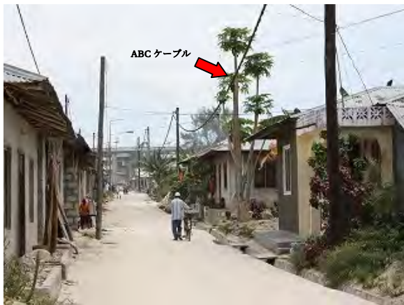
ABC ケーブル敷設状況 (ペンバ島)
