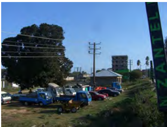
33 kV 配電線ルート (住宅密集地)
