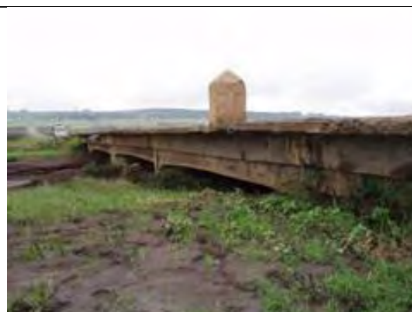
写真②：アベヤ橋
