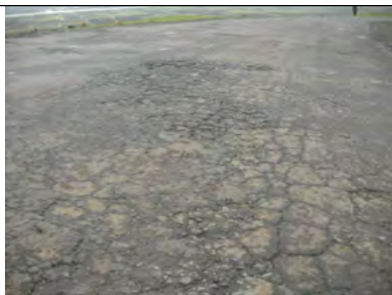
写真-7：舗装の状況
