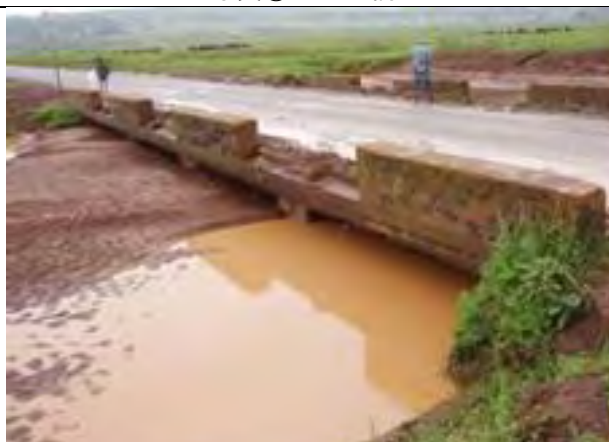
写真⑧：イエダ-2橋
