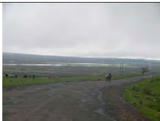
写真-8：低地部にブラックコットンソイルの堆積が見られ、舗装の破壊が著しい（イエダ川）
