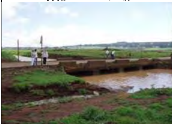
写真⑦：イエダ-1橋
