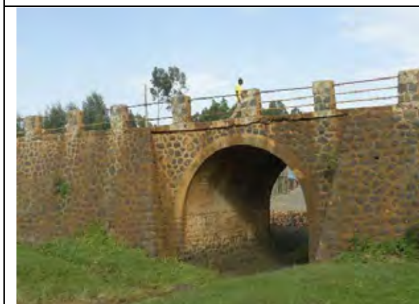
写真③：エキエト橋
