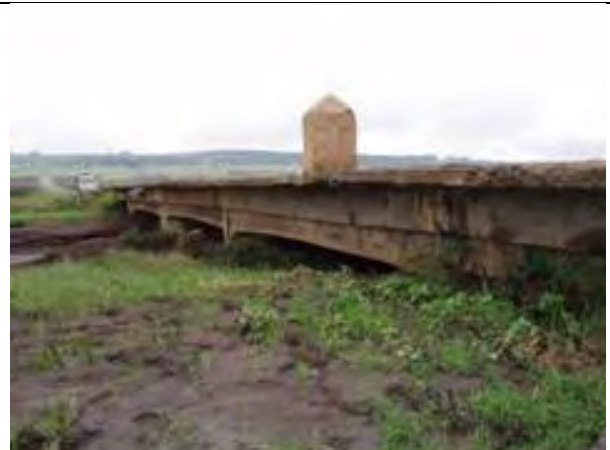
写真②：アベヤ橋
