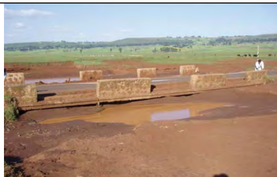
写真－8：低地部にブラックコットンソイルの堆積が見られ、舗装の破壊が著しい（イエダ川）
