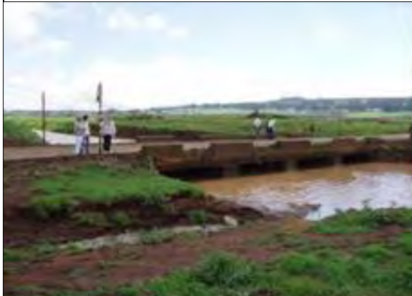
写真⑦：イエダ-1 橋
