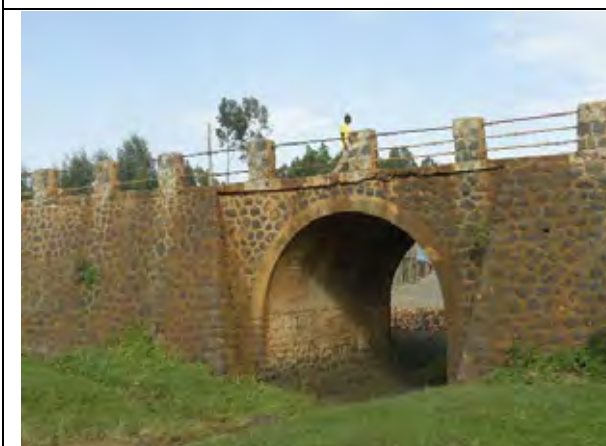
写真③：エキエト橋
