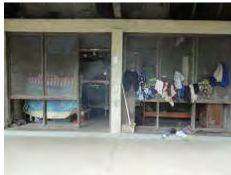
ソニウエイン大学の寄宿舎。洪水時に湛水し、1m高さの木製壁が流失し、修復せずにそのままの状態。
