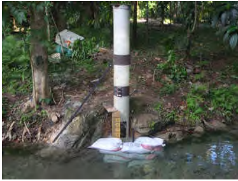
Pacific HYCOS で設置した水位計、データロガーは隣の立木に設置されている。機器は NIWA 製品
