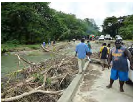
ホニアラへ繋がる幹線道路の橋梁は、まだ復旧していない。増水時には車両による渡河はできない。
