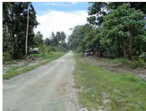
ホニアラへ繋ぐ幹線道路。2009年2月洪水では路面が冠水。未舗装状態のままになっている。
