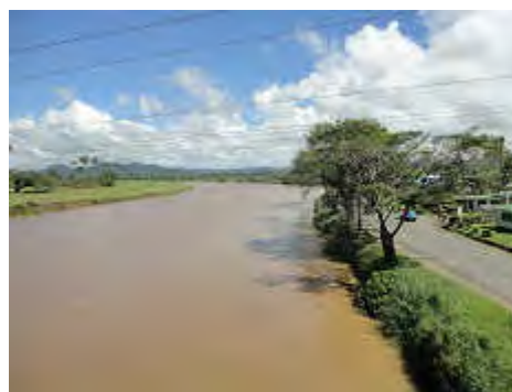
バ橋梁から下流河道の状況 (2010.3) 両岸とも後背地は低く、氾濫リスクが高い。 左岸側では河岸侵食が進んでいる。
