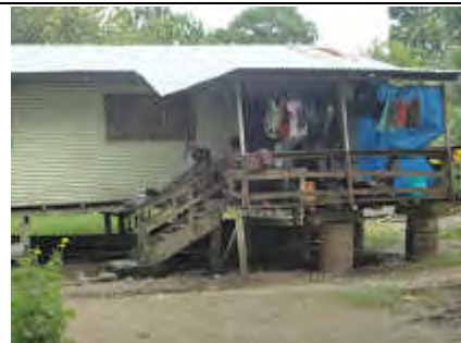
家屋の支柱が破損し、ドラム缶により支えている。危険な状態である。
