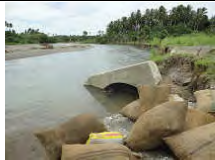
タンボコ川に架かる潜水橋の右岸部アバット周辺が洪水による局所洗掘で流失。落橋し、河岸侵食が進行
