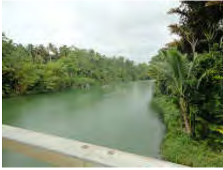
(1) 北部への幹線道路の Kwarea 川架橋地点。河岸周辺はニッパ椰子が繁茂。洪水は桁下と確認。
