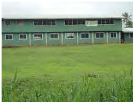
(4) Kwarea 地区の学校。河川より離れた高台にあるため、浸水問題はない。
