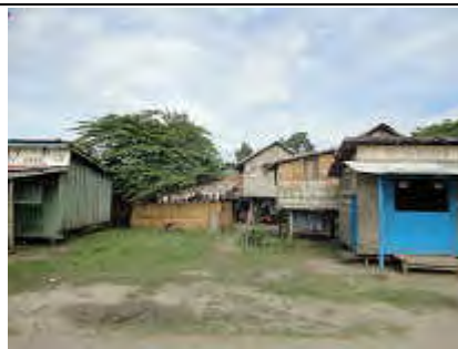
(2) Sun Valley 地区の住居、2009 年 1 月洪水での浸水家屋はなかった。
