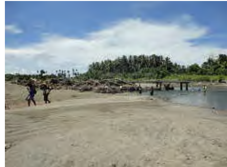
タンボコ川に架かる橋梁。2009年、2010年に被災したが、復旧工事が進んでいない。道路整備はADBで検討されている。
