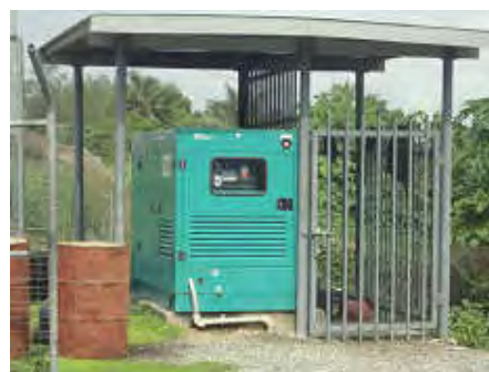
気象局及びホニアラ気象台の予備電源。市内の停電が多いため、重要な設備となっている。
