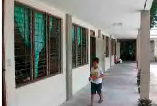
②廊下側の窓は開かない仕様。夜間利用を想定して廊下に蛍光灯が設置されている。（トラベシア小学校）
