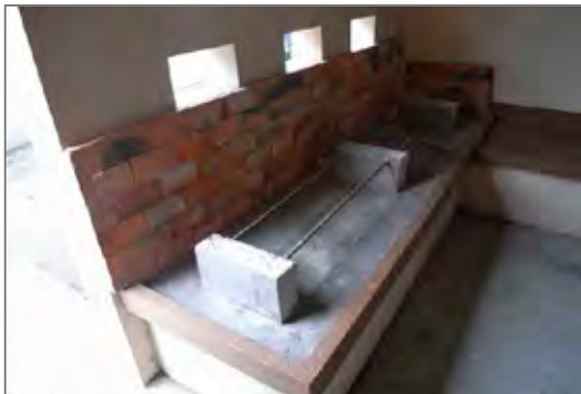
③半屋外にある炊事場。一部壁があるため雨風を凌ぐことが可能。（トラベシア小学校）
