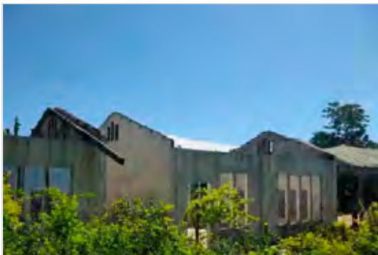
⑭台風により屋根が吹き飛ばされ、使用不可となった教室。
