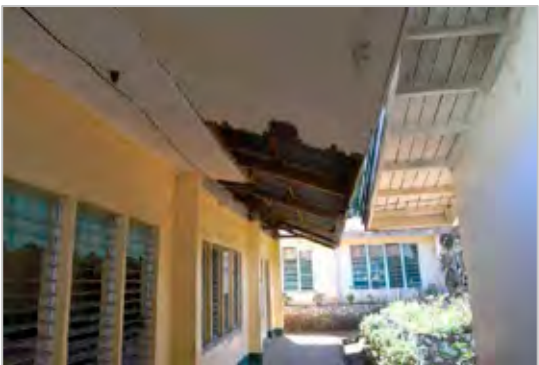
⑮本来は多目的室であるが、教室不足のため就学準備課程の児童が使用している。軒の損傷が激しい。
