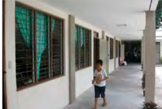
②廊下側の窓は開かない仕様。夜間利用を想定して廊下に蛍光灯が設置されている。（トラベシア小学校）
