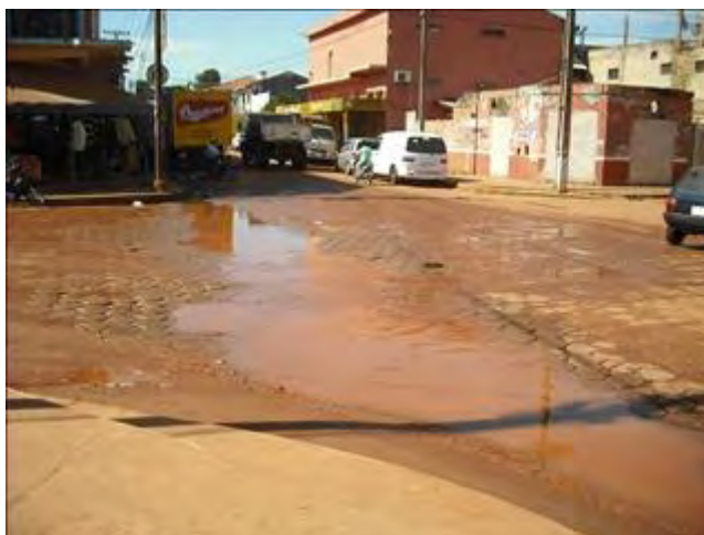
参考写真 配水本管 Brasil 通りの漏水
