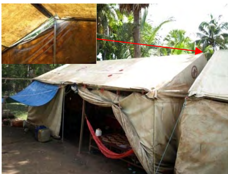
老朽化したテント
