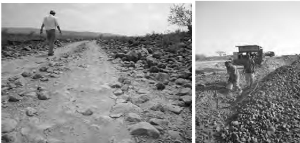
**Figure 2-2-24** Les sites concernés sont généralement couverts de basaltes – roches dures (gauche) Terrassement par engin briseur pour pose de canalisations (droite)
