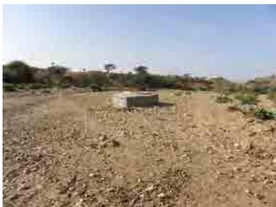
Photo-10 : Puits peu profond situé le long d'un wadi sous une forme d'un bateau dont la proue pointue orientée vers l'amont semble résister contre le cours d'eau d'inondation.
