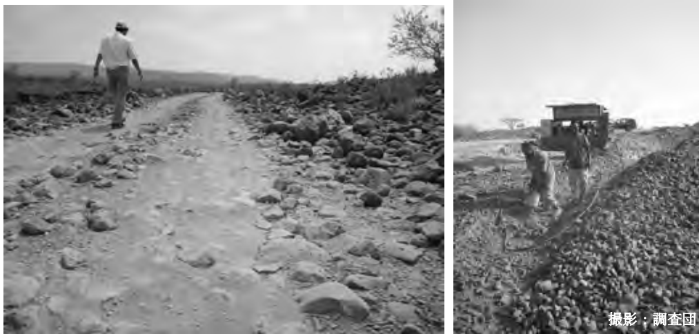
図 3-2-24 対象サイトは基本的に玄武岩（硬岩）に覆われている（左図） 玄武岩に管路を敷設するためブレイカーを使用（右図）
