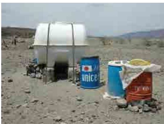
写真-9：ユニセフが水源の無い地域の国道沿いに設置している給水タンク。定期的に給水車で水を配給する(Dikhil 県 Daguïro)。
