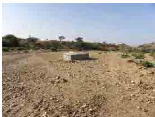
写真 10 ワジ沿いに設置された浅井戸。洪水時に水流に対抗するように水流上流側が船の舳先のように尖っている。
