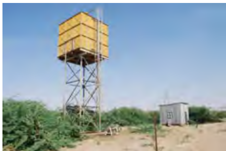
写真-2.21.1 給水タンク (27m 3 )
