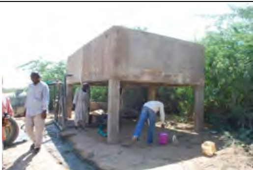
写真-2.3.11 給水タンク(コンクリート製)
