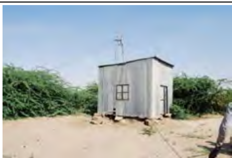
写真-2.21.3 井戸管理用施設
