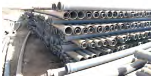
写真-2.5.2 市街地交換用 PVC パイプ
