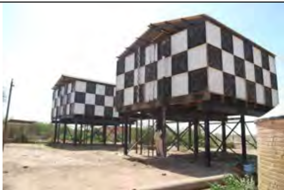
写真-2.5.5 給水タンク 4 基 (147m 3 ×2、50m 3 、24m 3 )
