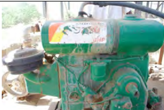
写真-2.5.6 揚水用ポンプ (13.4kw)
