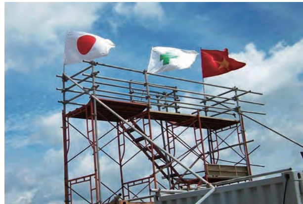
Cờ an toàn treo tại công trường cảng Cái Mép
