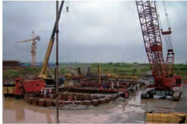
Tình hình thi công chân cầu P14
