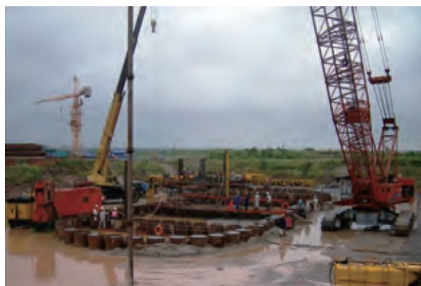
P14 橋脚施工状況
