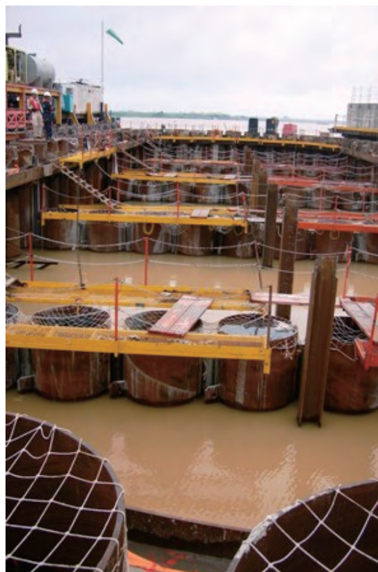
鋼管内墜落防止・ユニット足場
