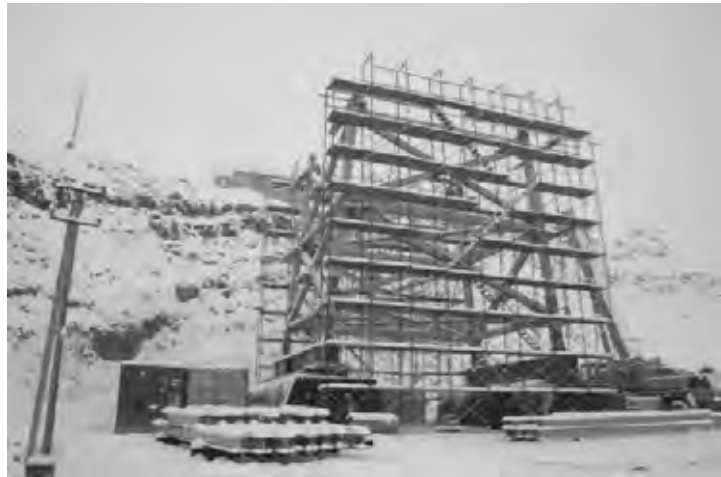
トラス橋脚 (No.4 橋)
