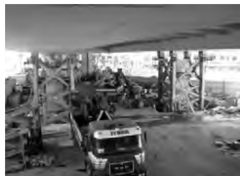
Mecidiyeköy 高架橋 ベント設置状況
