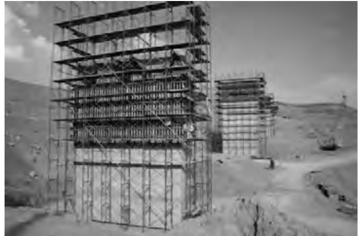
橋脚型枠・足場状況 (No.3 橋)
