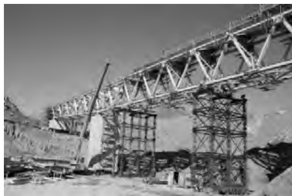
鋼床版架設状況 (No.5 橋)
