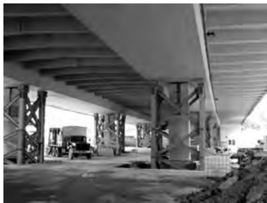
Mecidiyeköy 高架橋現場状況
