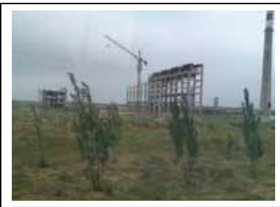
杭锦旗 新しいプラントの建設
