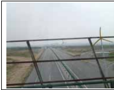
中央分離帯上の風力発電装置
