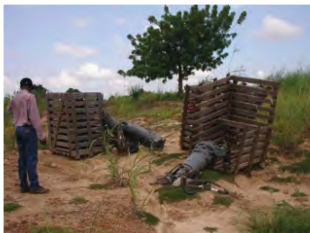
設置されずに現場に放置されている水中ポンプ
