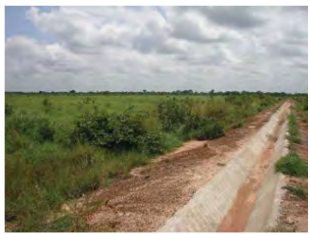
コンクリート舗装されている2次水路、圃場内は未整備
