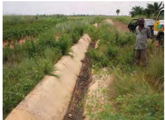
圃場内の幹線水路
