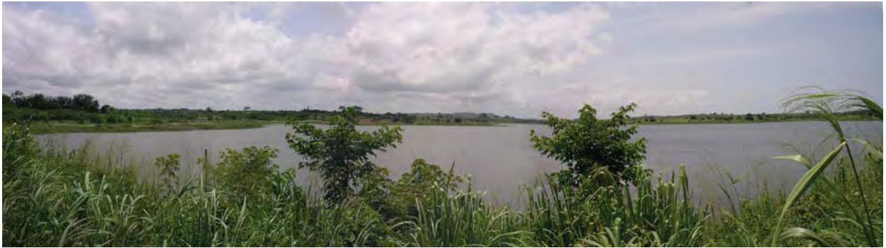
Okyereko 貯水池（灌漑用水の水源、有効貯水容量 2.7 million m 3 ）
