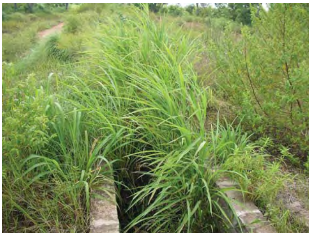
頭首工からのコンクリートブロック仕様の幹線水路
