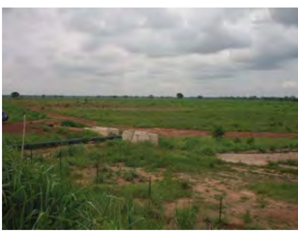
夜間貯水池から伸びるパイプと分水施設。その向こうには灌漑地区が広がるが、圃場内未整備のため未利用。
