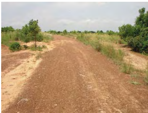
圃場内の幹線道路、ラテライト舗装
