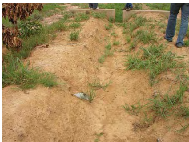
土水路の2次水路と圃場への取水パイプ。取水パイプは目詰まりしやすく、農民には不評。
