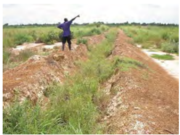
コンクリート舗装されている3本の2次水路以外は、未舗装のまま残されており、漏水の不安がある。
