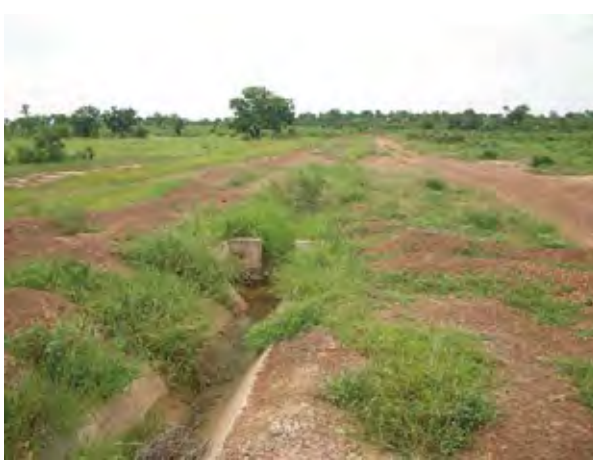
コンクリート舗装されている幹線水路末端部、延長計画がある。
