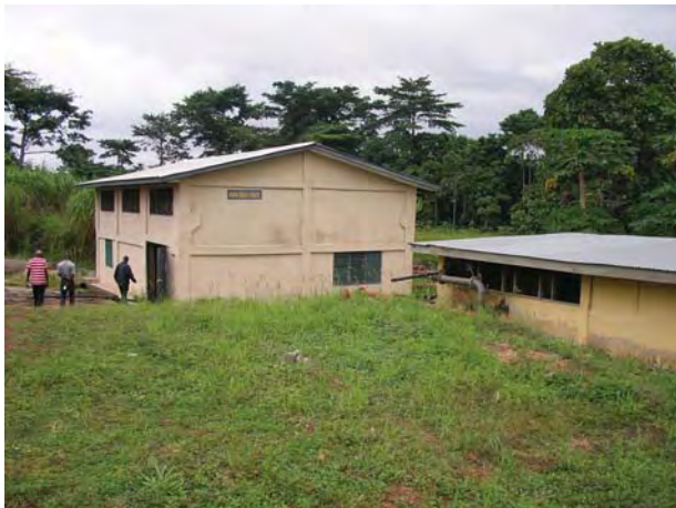
完成済みポンプ場、試験運転も行われている。
