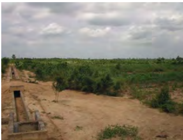
第1 二次水路と灌漑予定地区。圃場整備が行われていないため、未使用。
