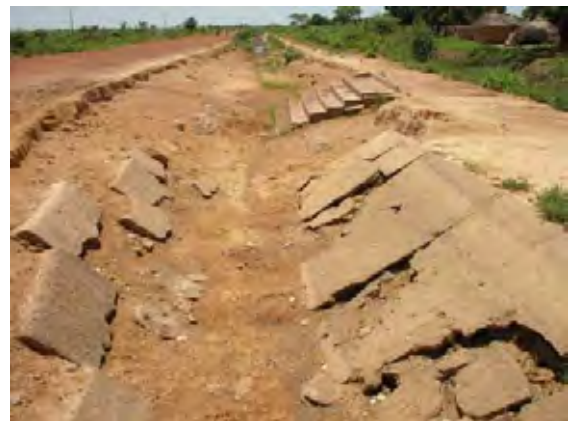
第 1 幹線水路の状況
