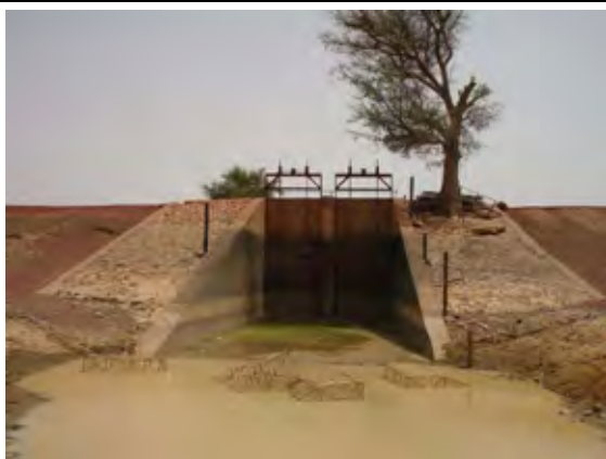
隣接するサレマレ灌漑地区の取水工
