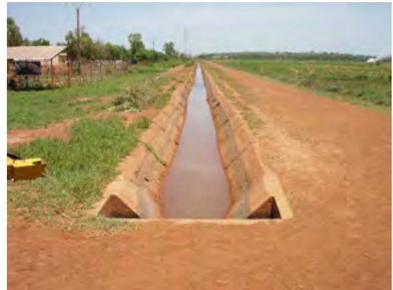
二次水路は 2001 年にコンクリート舗装されている
