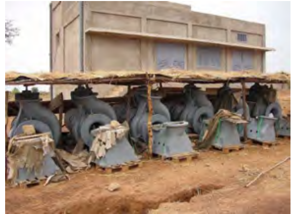
据付を待つポンプ6基（製造者プレートがない）
