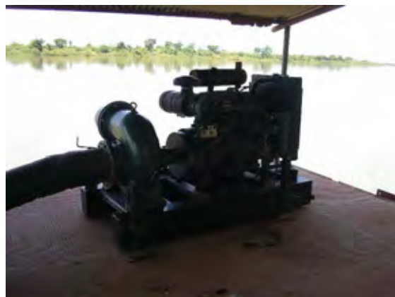
ポンプ場が利用できなくなつてからは、小型ポンプを直接ニジェール河に設置し取水している
