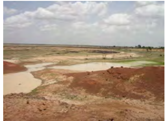
完成後 4 年で幹線水路は滞砂のため消えている
