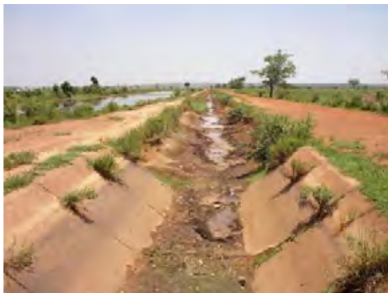
第 1 幹線水路の状況
