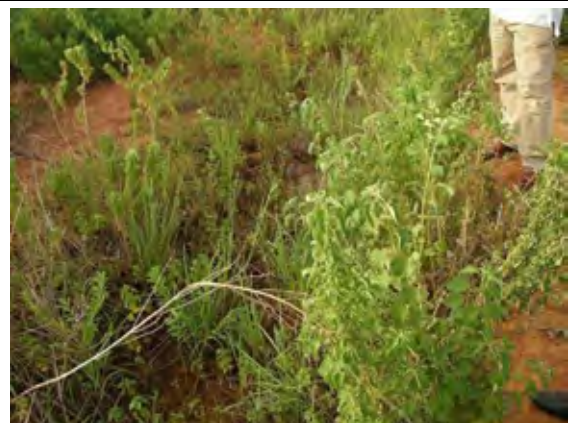
2次水路は土水路、水路からの水損失を防ぐため、コンクリート舗装を要請している
