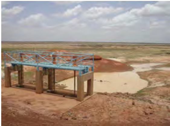
WOLONI 地区水位制御水門と幹線水路
