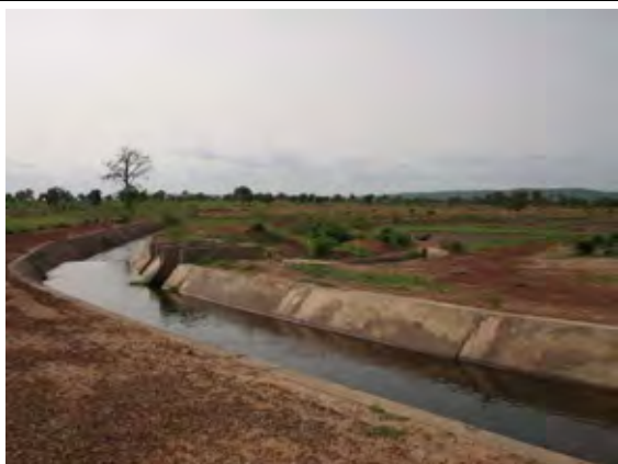
幹線水路はコンクリート舗装されている
