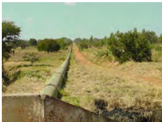
ザンビアシュガーからの灌漑用パイプライン
