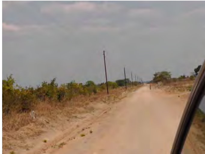
受益地区にはポンプ運転用の電気が準備されている。
