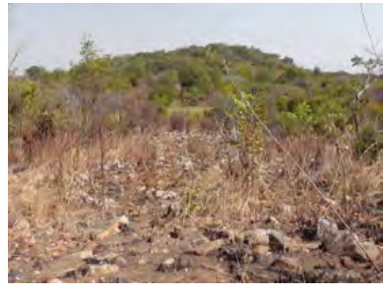
ダムサイト左岸アバットから 右岸アバットを展望する。
