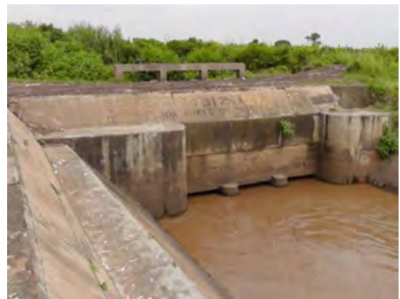
ドホ頭首工の取水工
