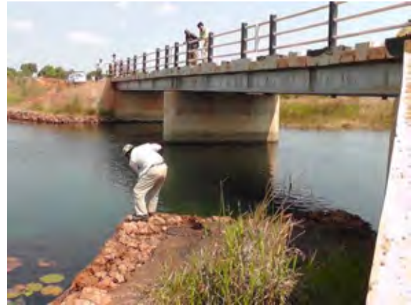
カルング川下流の橋梁地点
