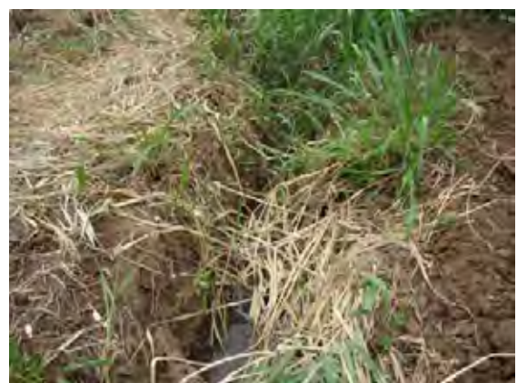
第2次水路 (滞砂で埋まっている)
