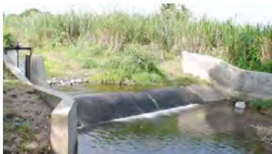
ムブク 頭首工
