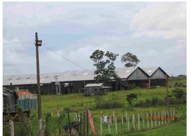
パンド県資機材置き場・機材倉庫予定地
