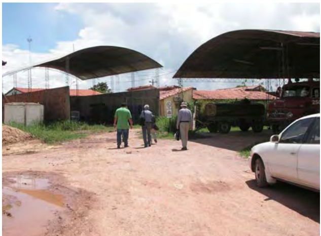
ベニ県資機材置き場・機材倉庫予定地
