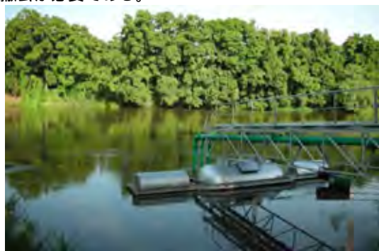
写真-2 既存浄水場（取水施設）
