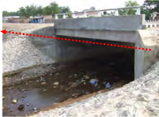
写真-12 水管橋架設箇所
