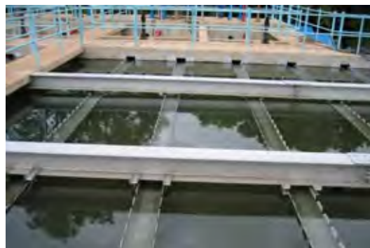
写真-3 既存浄水場（沈澱池）
