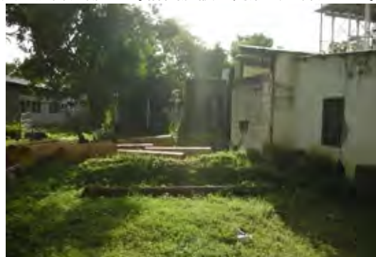
写真-5 撤去対象施設
