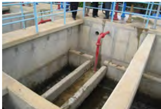
写真-4 既存浄水場（ろ過池）
