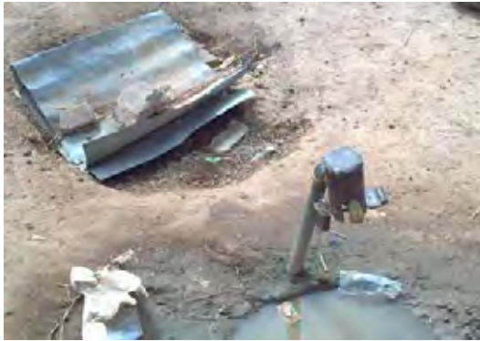
写真-1 公共水栓 他ドナーの支援で建設された施設。取付方法 が悪いため新規に建設する (クンペントウム)
