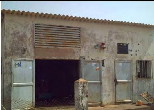
写真-5 機械室 屋根交換・建具交換・再塗装を実施する (シンチュウ・マレム)
