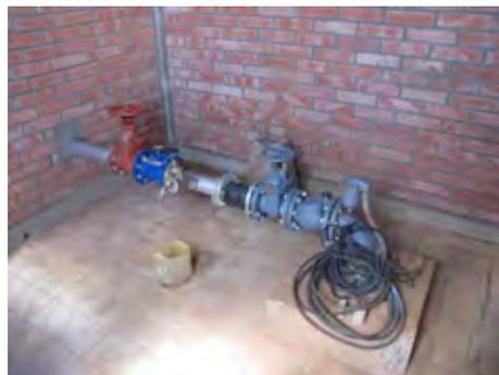
Tilata 浄水場近くの井戸 No.9 井戸径は 250mm、生産量は 6m<sup>3</sup>/hr、維持管理は適切に実施されている。
