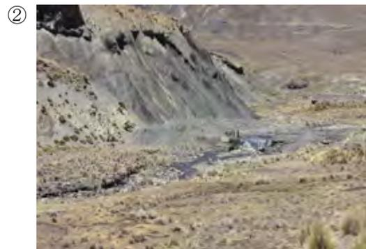
写真①はHuayna Potosi西に設置されている流量観測施設である。三角堰が堤体の中央部にある。堤体上流側は堆積土砂が多く、三角堰までの定常流が確保されていない。
