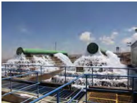
El Alto 浄水場のエアレーション装置。
