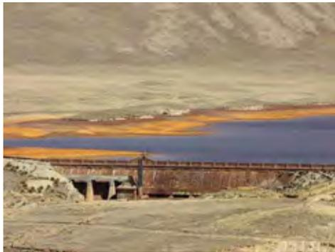
Milluni ダム：標高 4480m、1911 年竣工、貯水量 9,500 千 m<sup>3</sup>、上流部にある鉱山からの廃液により汚染されている。
