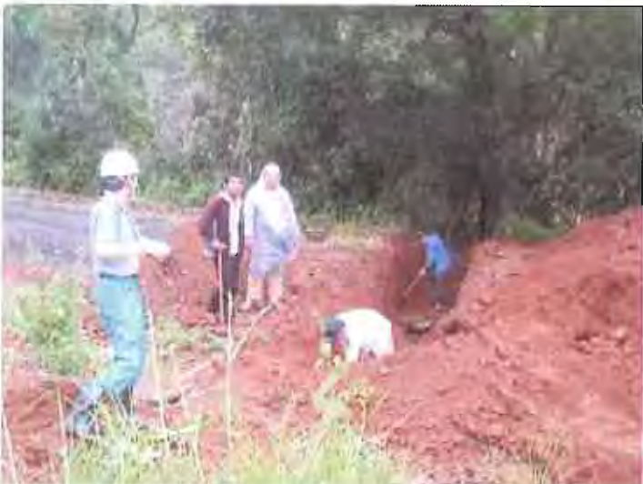
○工事中 掘削中の状況
