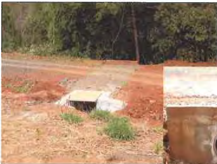
○工事後 完成後の状況
