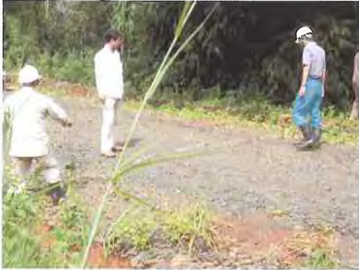
○工事前 測量中の状況
