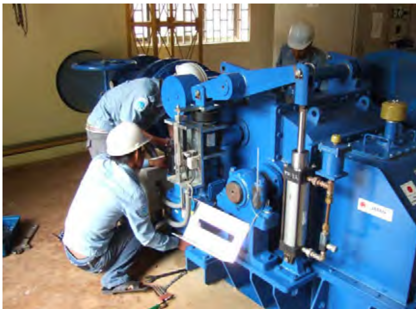
オロミス発電所定期点検 2010年6月2日
