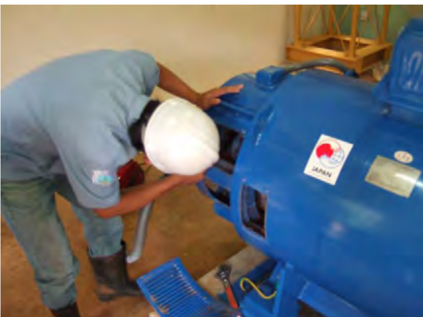
オモレン発電所定期点検 2010年6月5日
