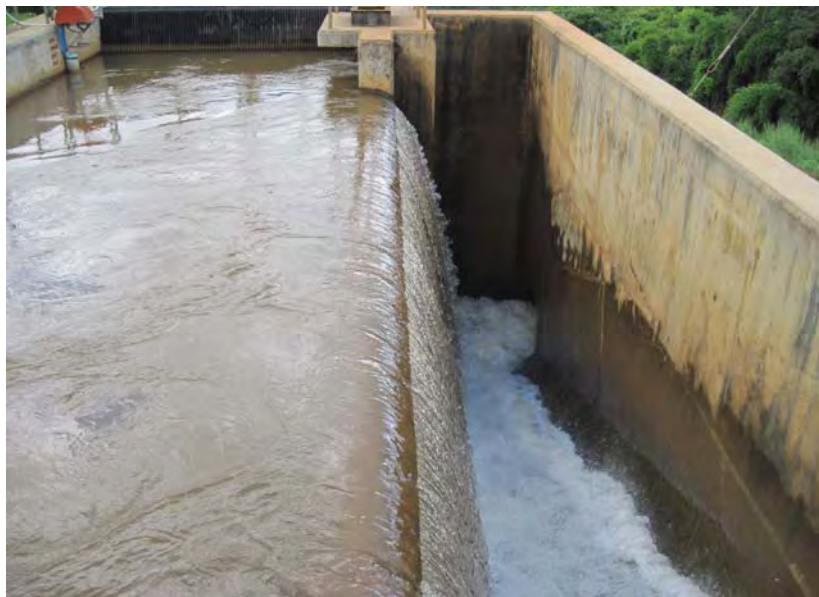
ヘッドタンクからの越流状況
