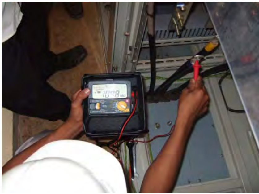
オロミス発電所定期点検 2010年6月3日
