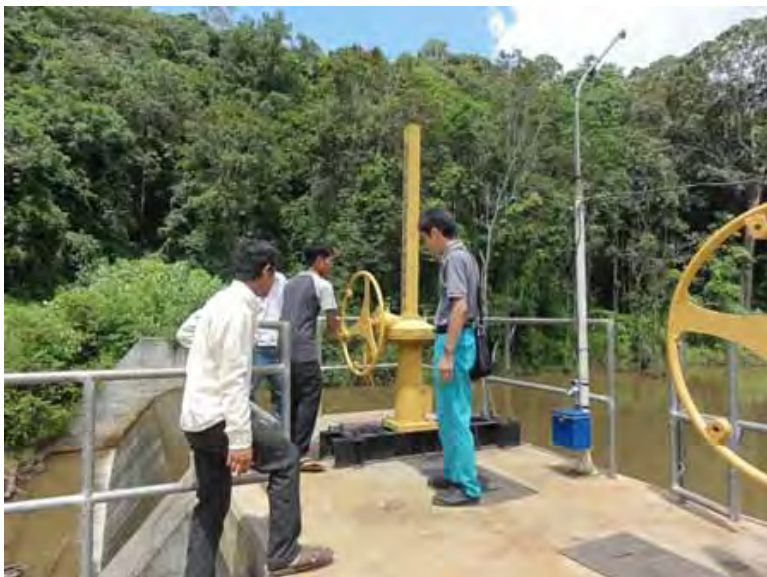
排砂指導 オロミス発電所で排ゲートの 操作方法を指導
