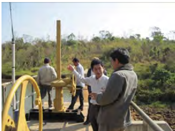
JICA 調査団オモレン水力発電所視察状況
