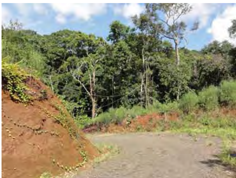
アクセスパス街路灯配線 道路からのクリアランスが小さい
