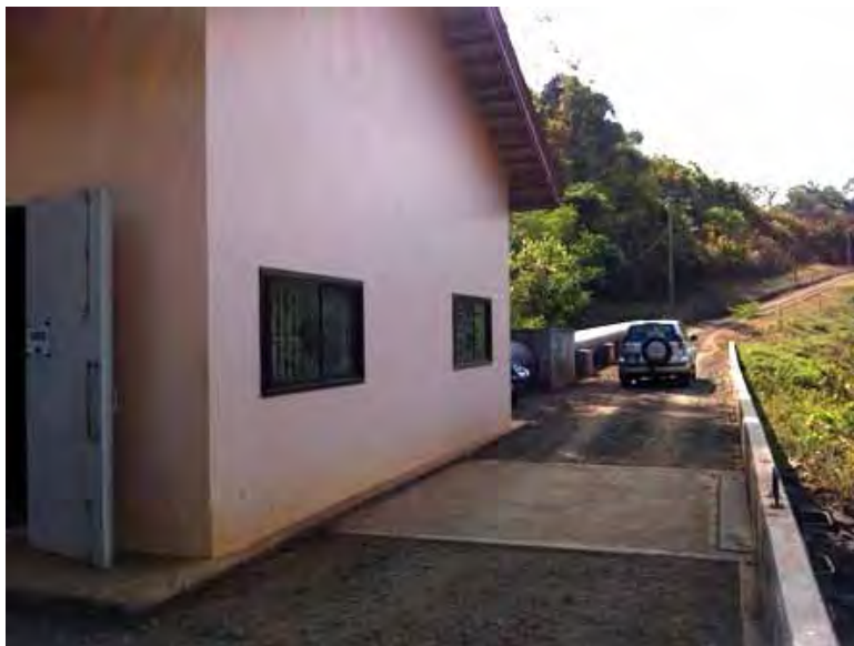
オモレン発電所付近の状況
