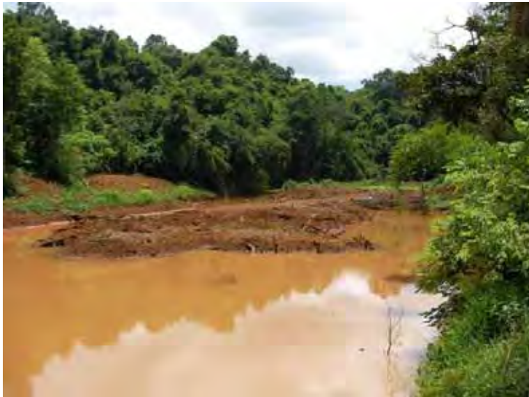
貯水池内に放置された仮設道 (取水堰から上流を望む)
