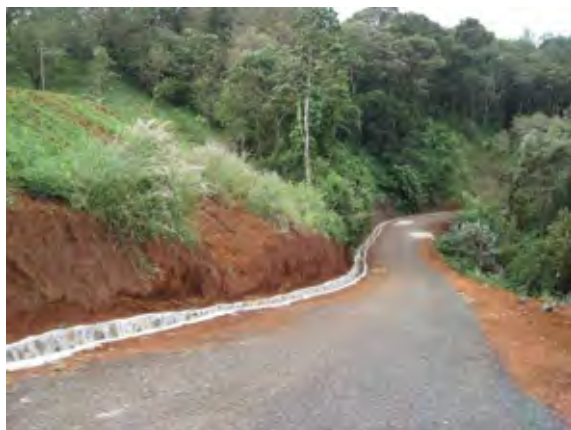
国道 76 号からの進入口
