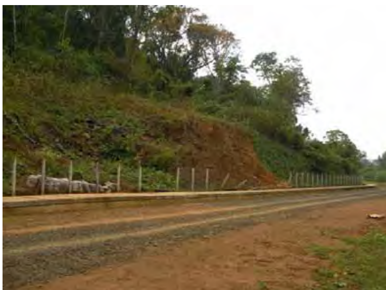
【参考】 工事前の状況（2009年12月）
