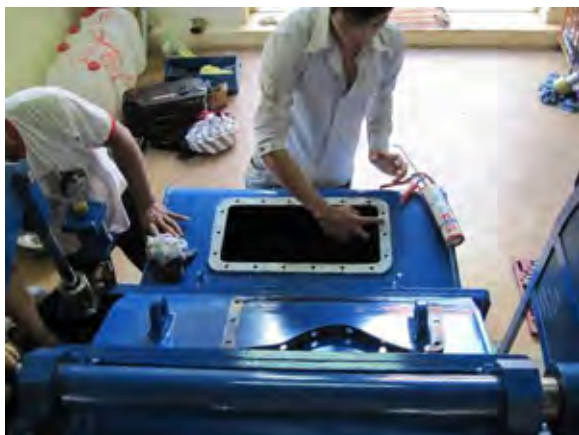
オモレン水力水車分解点検
