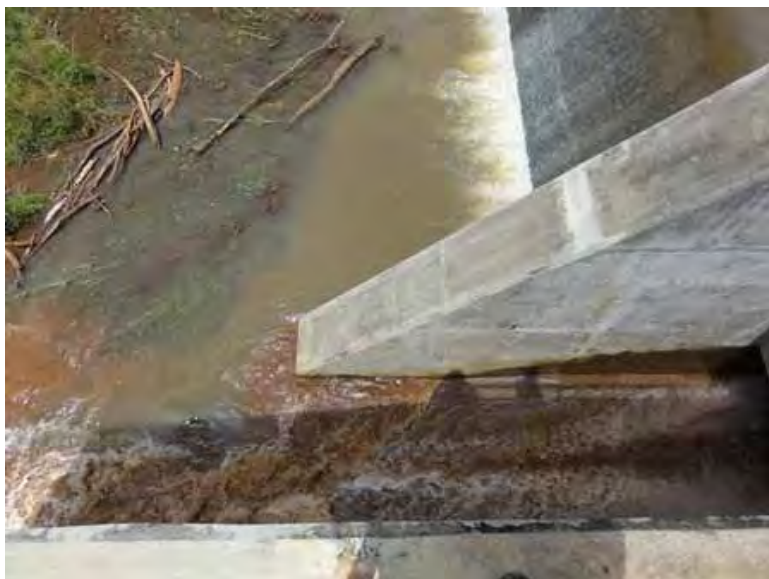
排砂状況 排砂ゲート解放直後の状況
