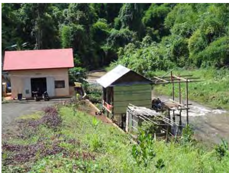
河川内の家 洪水時に流出の危険があるため、移設を指導
