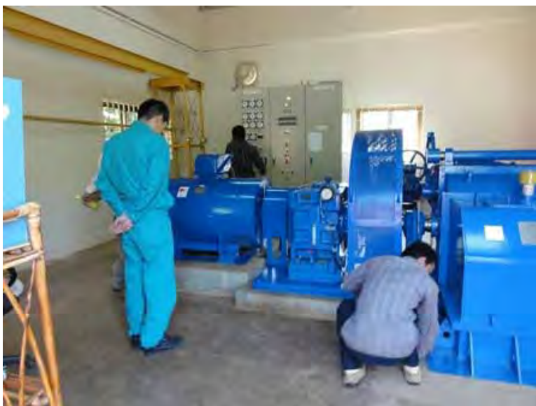
パトロール状況 (オモレン発電所) 建屋内機械基礎の点検
