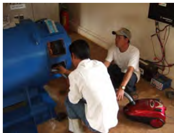
同・発電機清掃、点検
