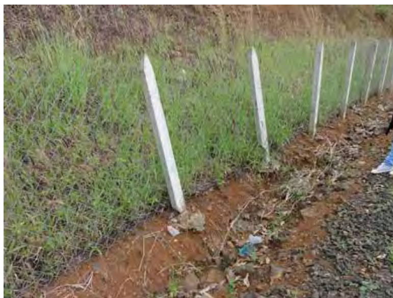
オモレン発電所 イノシシが衝突した支柱
