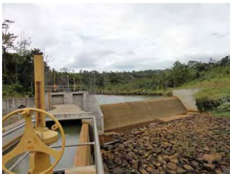
オモレン発電所 取水堰の現況。堰からの越流は なかった。 撮影時の発電電力 100kW。
