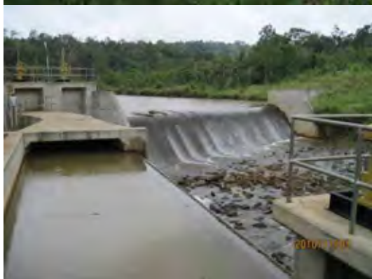
オモレン水力発電所取水ダム 越流状況
