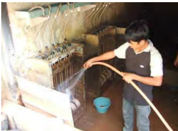
オモレン水力発電所・ダミーロード清掃、点検
