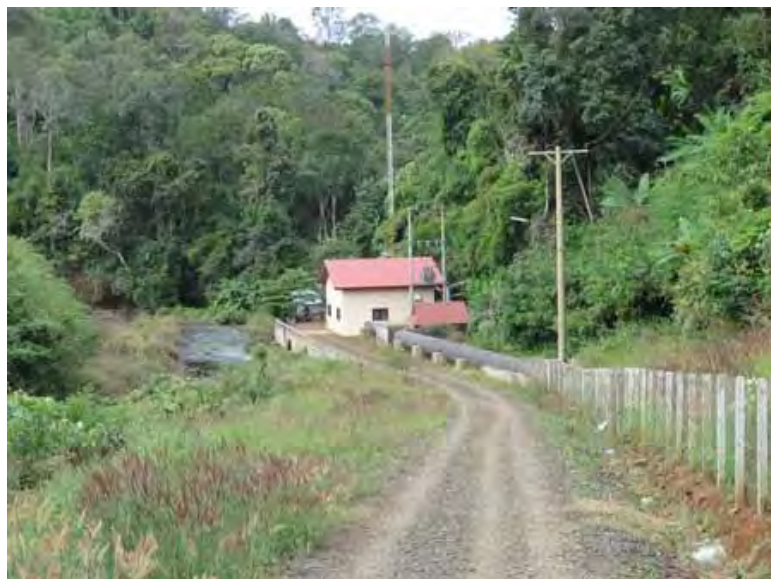
オモレン発電所 発電所の現況
