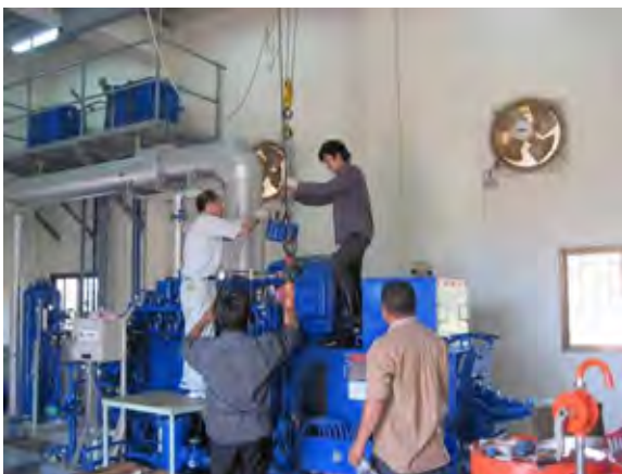
DG シリンダー内部組み立て状況
