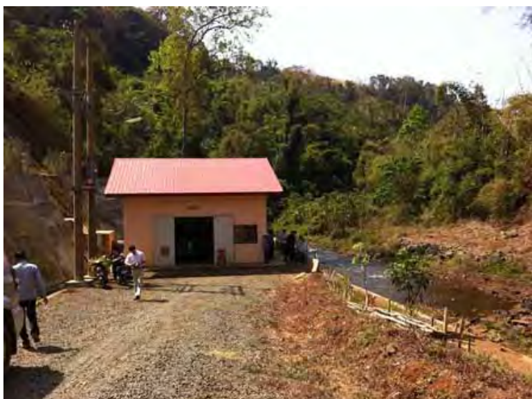
オロミス発電所付近の状況
