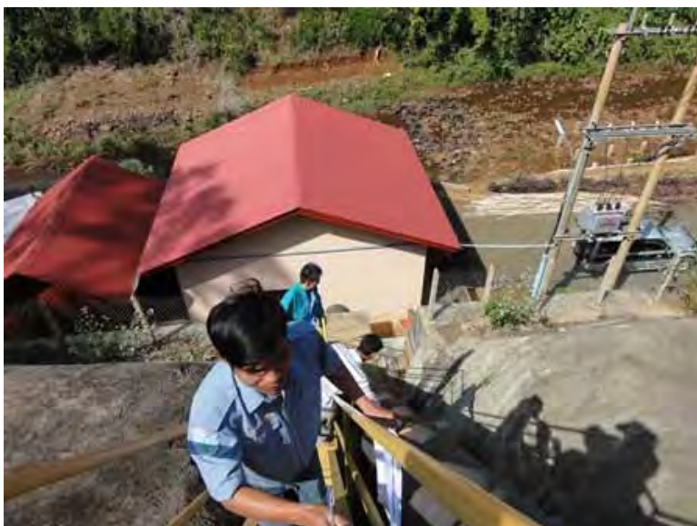
パトロール状況 (オロミス発電所) 水圧鉄管の点検状況
