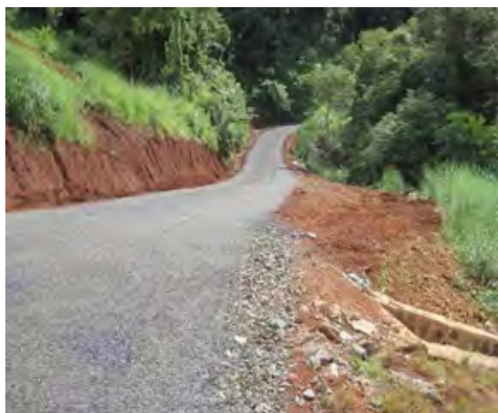
国道 76 号からの進入口（補修後）
