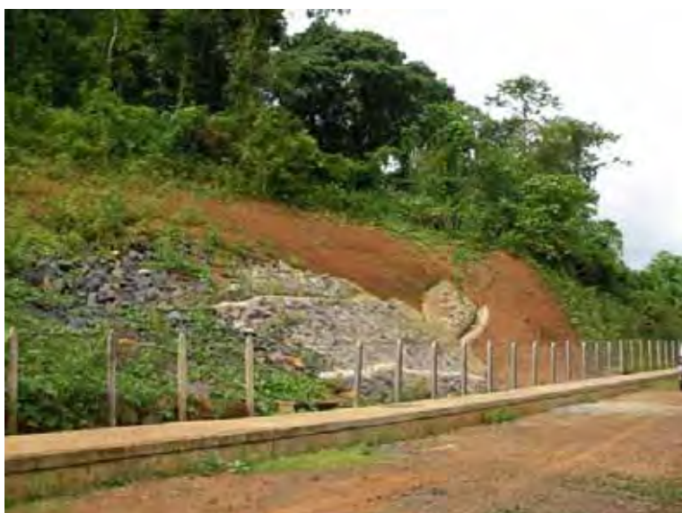
オロミス発電所アクセスパス沿 い法面補修状況
