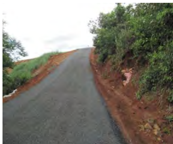
オロミス発電所から国道への出口（補修後）
