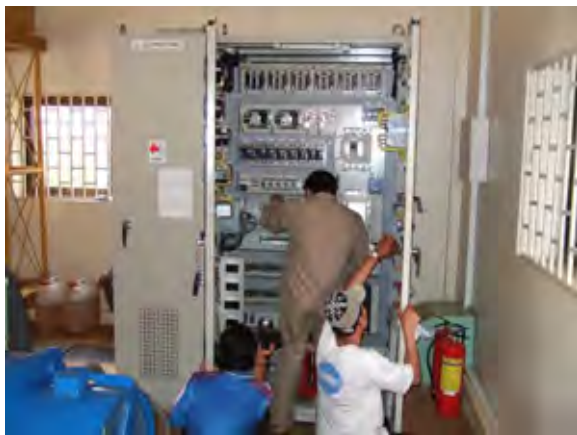
水車制御盤内部点検 および測定状況
