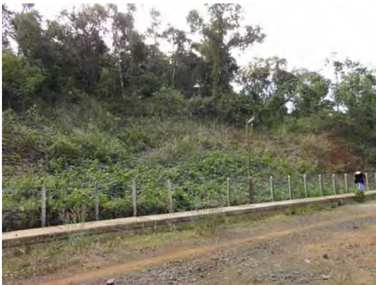
オロミス発電所 昨年度補修した法面箇所。 現在は安定している。
