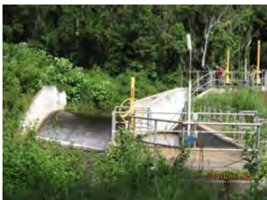
オロミス水力発電所取水ダム 越流状況
