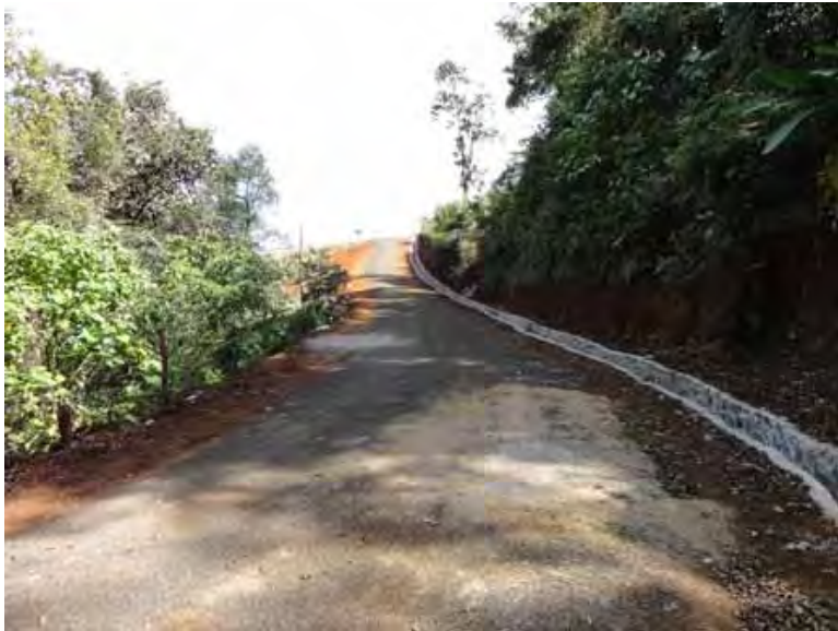
オロミス発電所 入口付近アクセスパスの改良状 況。
