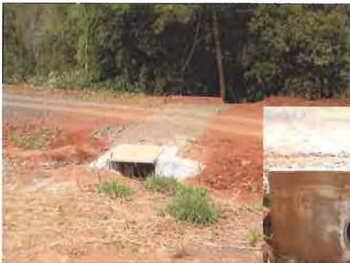
○工事後 完成後の状況
