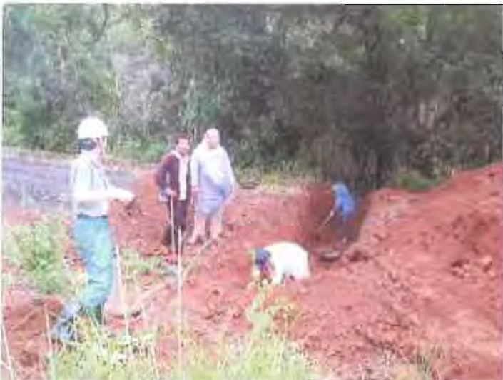
○工事中 掘削中の状況
