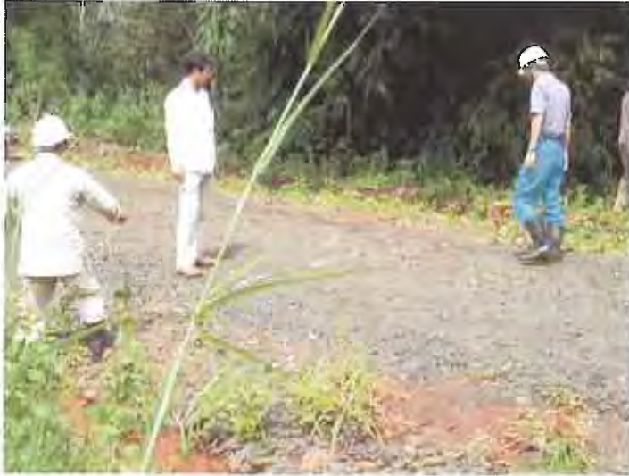
○工事前 測量中の状況
