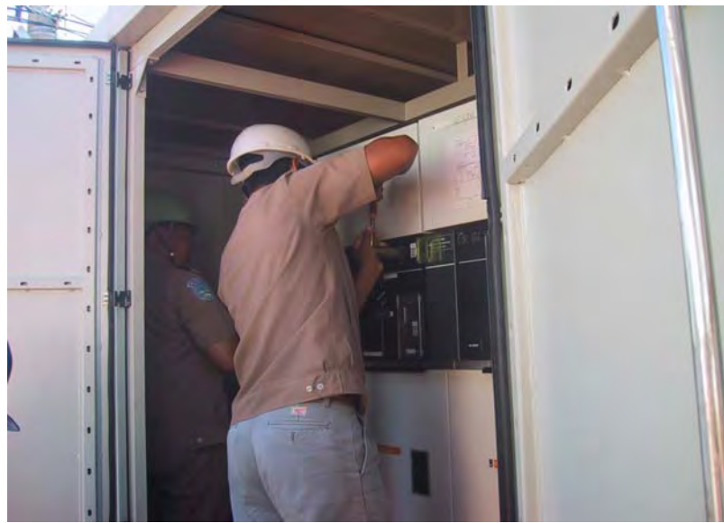
停止作業の開閉器操作状況
