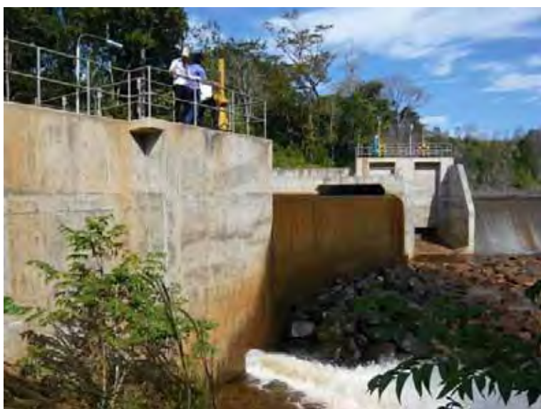
オモレン発電所沈砂池排水状況 オモレン発電所沈砂池のサンドレインゲートを開放し、沈砂池内の水および堆砂を排出
