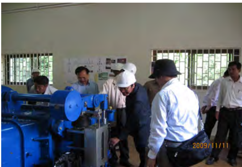
瑕疵検査状況 (オロミス水力発電機器)
