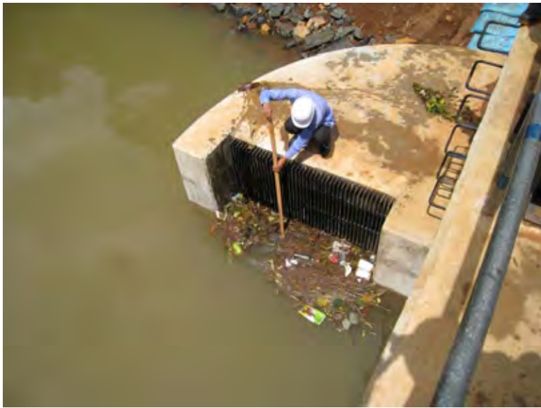
オロミス取水口の除塵作業訓練
