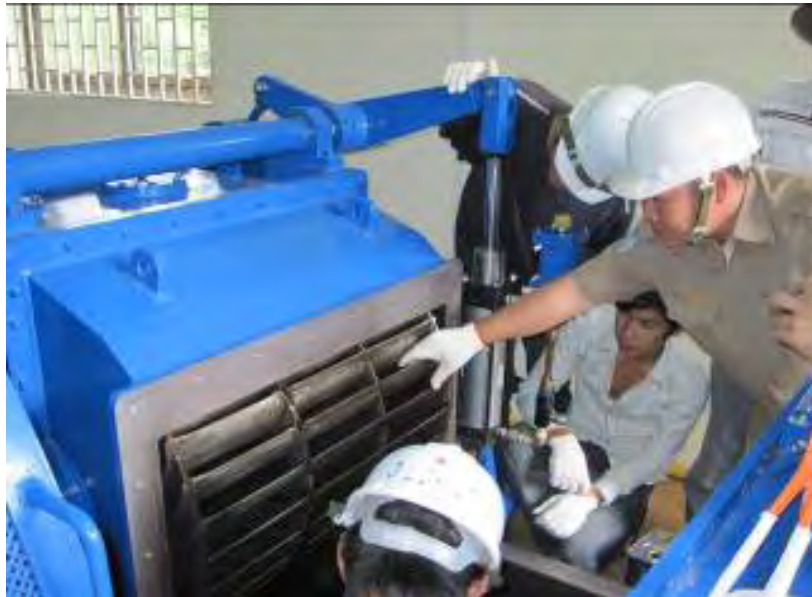
オモレン水力発電所 水車ランナー内点検状況
