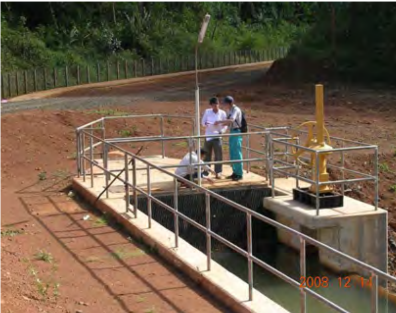
オロミス沈砂池点検訓練状況
