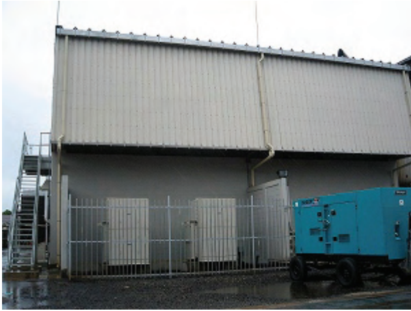
キングトム発電所：無償資金協力によって建設された建屋
