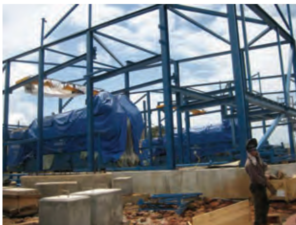
6. ブラックホールロード発電所：据付中のワルチラ発電機
