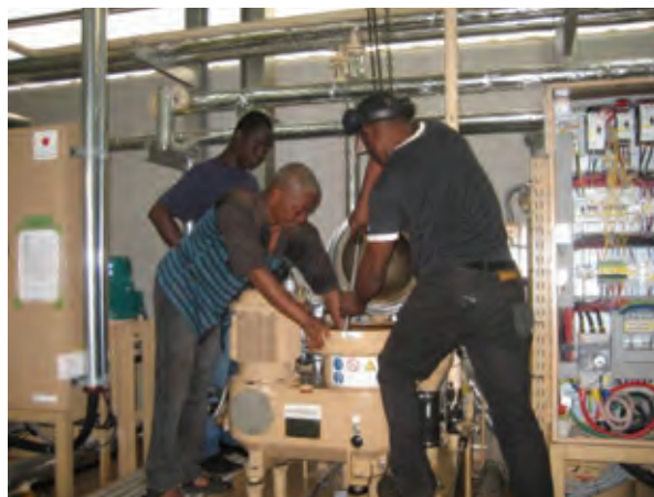
2. 新潟発電機 No. 2 燃料ピュリファイヤーの整備作業
