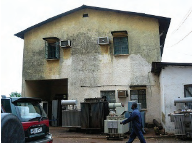
ファルコンブリッジ変電所：事務所外観
