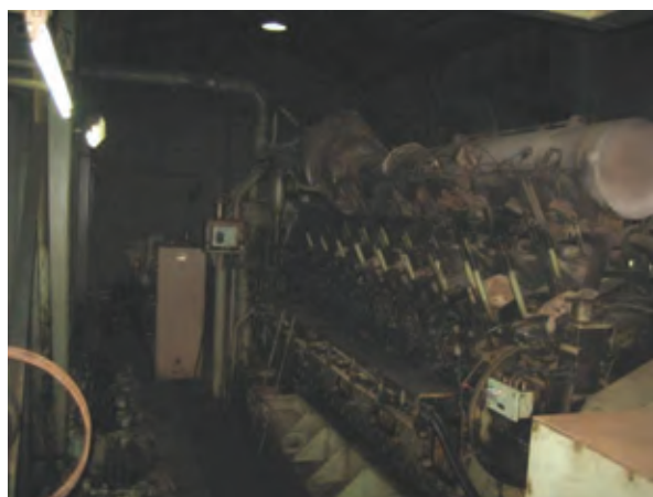
4. 三菱 6 号発電機エンジンの現状（開放作業中のまま放置されている）
