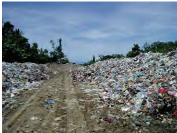
カルバヨグ市既存処分場
