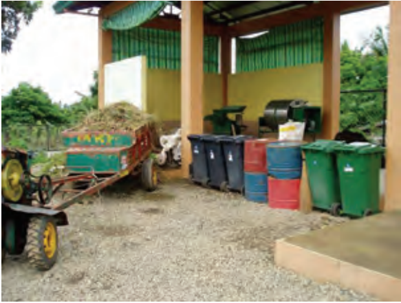
サガイ市パイロット MRF 施設
