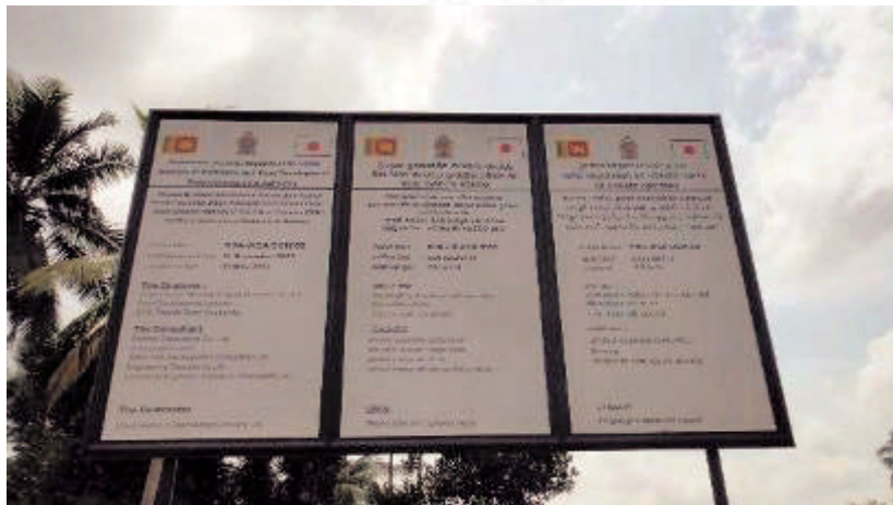
写真 18 OCH (Kaduwela-Kottawa 区間) の工事案内板・コンサルタントはオリエンタルコンサルタントを中心とする JV、コントラクターは China Harbour Engineering Company, 工期は 2009 年 12 月～2013 年 5 月
