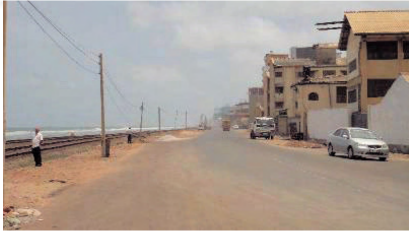
写真 16 マリンドライブ道路現地状況・ほぼ工事完了で一部の出入り口から交通開放していた
