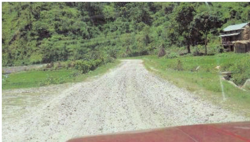
写真 11 一部（ネパール施工部分）にまだ、砂利道がある
