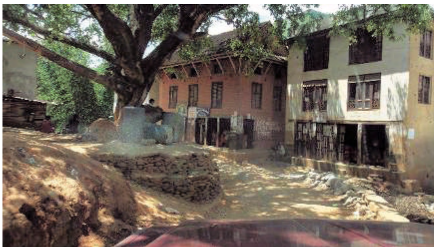
写真 15 第3工区現道。工事中の道路は別ルートをとる
