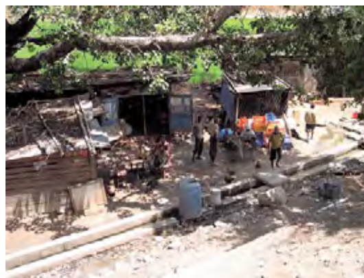
写真8 シンズリ道路第三工区入口付近
