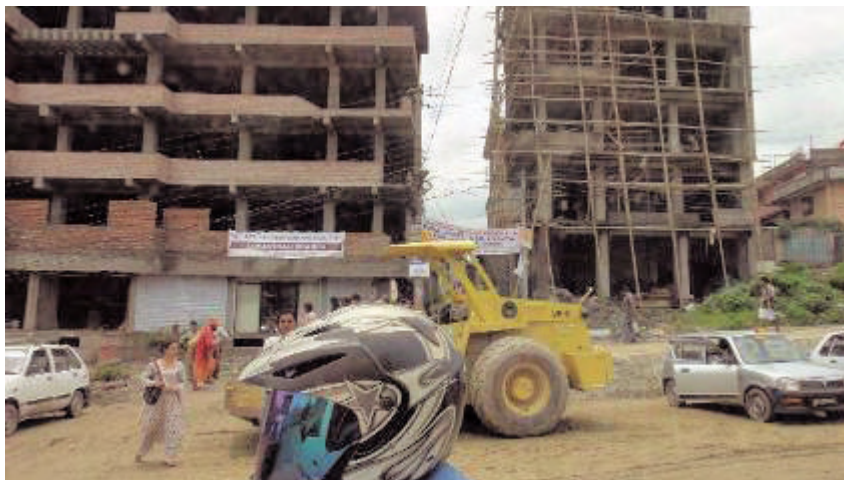
写真 4 重機がみえる
