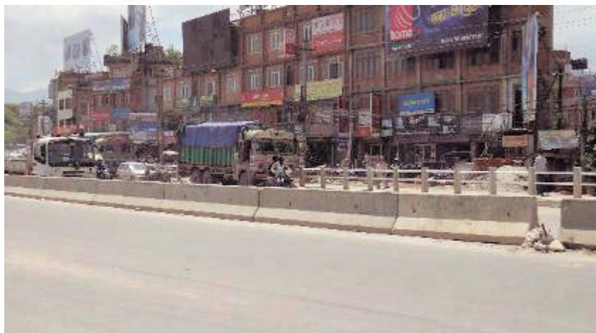
写真 1 カトマンズ・バクタプール道路工事中の状況
