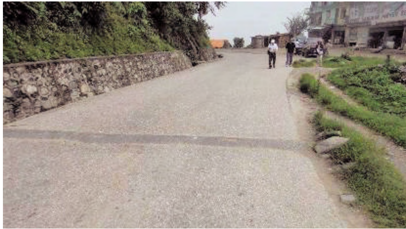
写真 7 開通後第 4 工区の状況
