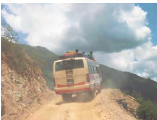
写真11 シンズリ道路 第三工区坂道
