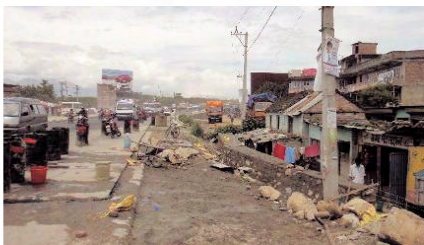
写真 2 右側の建物は支障物件として、交渉に時間がかかったもの。 最終的には、立退に応ぜず、保証金を支払い安全のため防護壁を設置。
