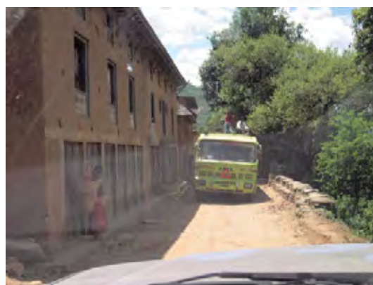
写真12 シンズリ道路 第三工区
