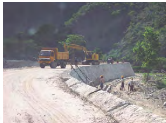
写真6 シンズリ道路第三工区の工事
