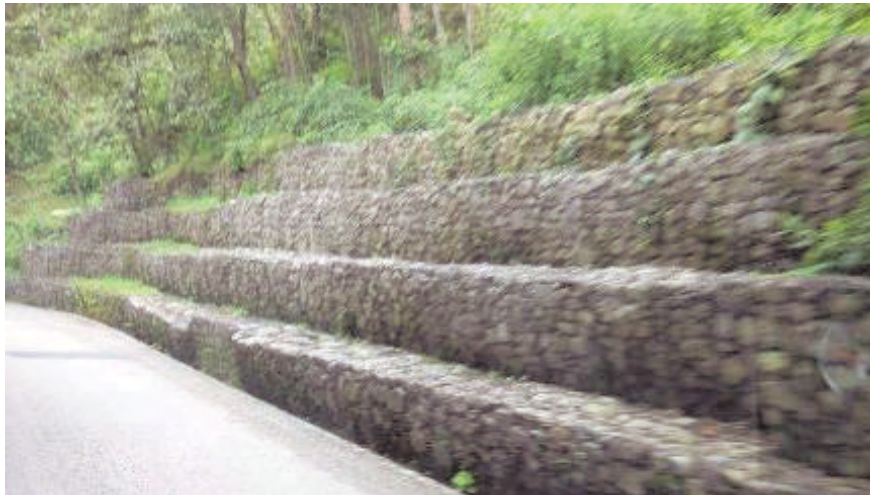
写真 8 蛇籠が斜面对策に用いられている
