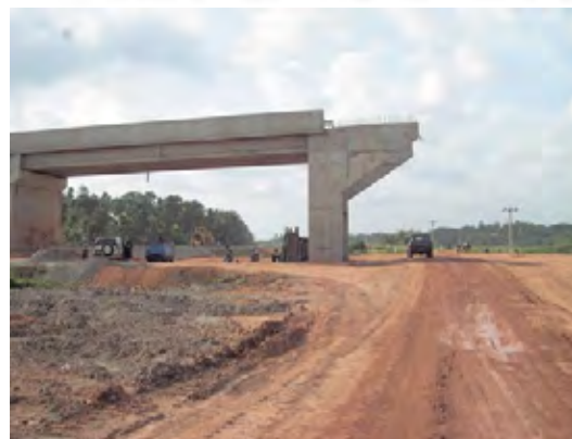
写真6 高速道路建設風景
