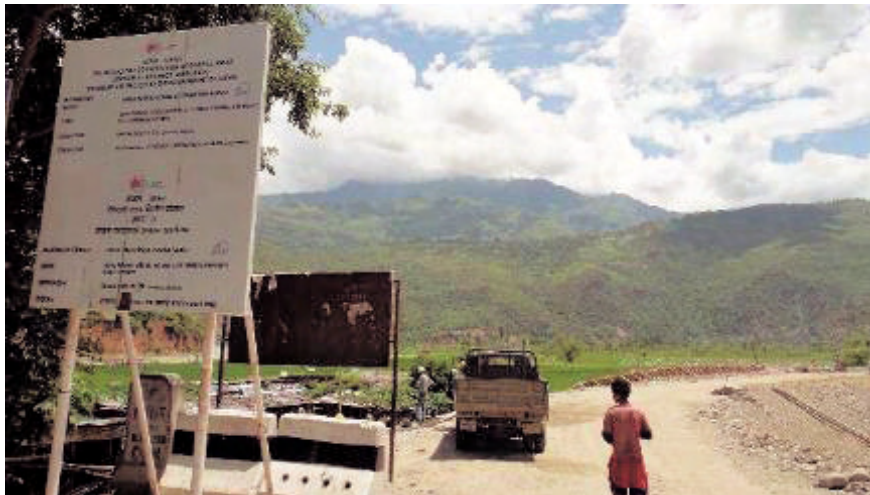
写真 14 第3工区工事状況
