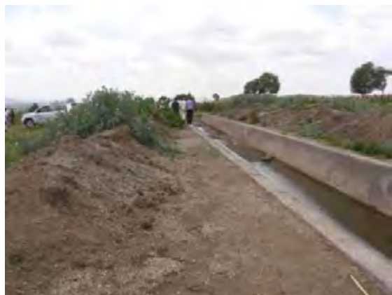
ブラサイト、OJTで建設途中の主水路 農民負担を求めつつ延伸予定
