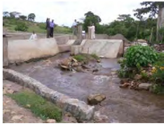
ブラ(Bura)サイト、OJTで建設途中の頭首工
