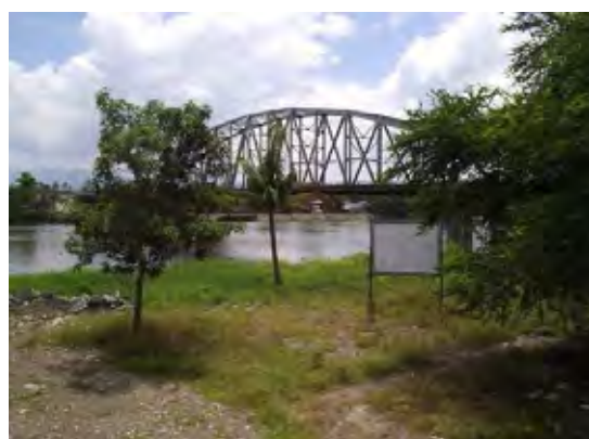
立て替えが決定している第一マグサイサイ橋
