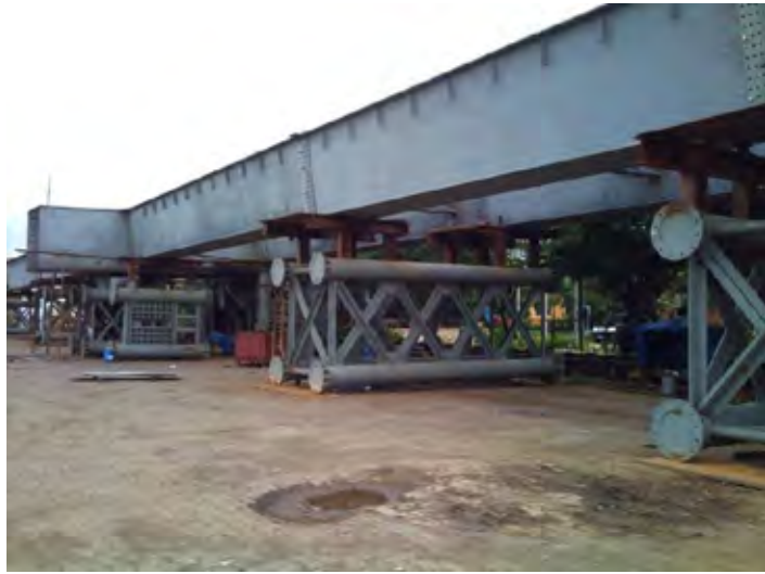
写真：バクリーメタル、橋桁の仮組み
