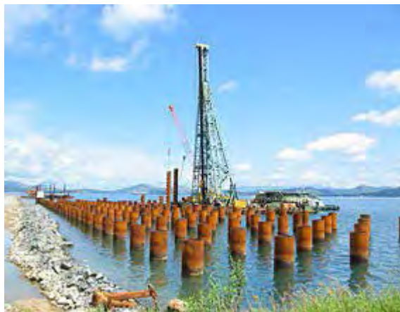
工事中（杭打ち工事）の写真
