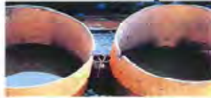
図 7-2 鋼管矢板井筒工法
