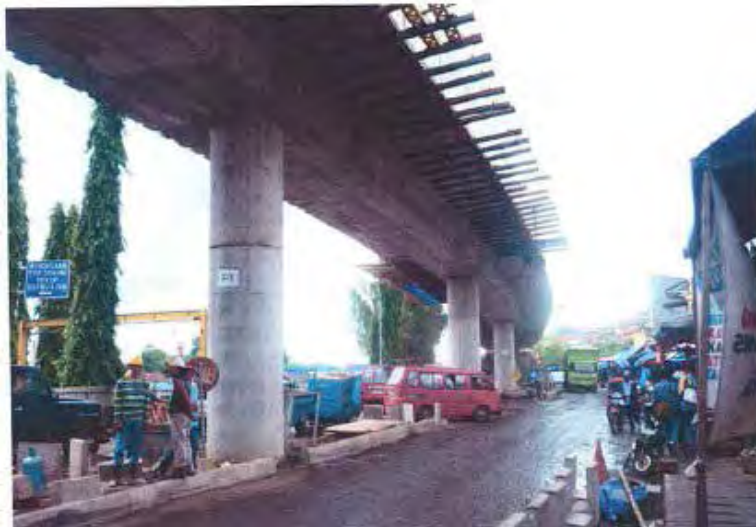
写真：メラックの工事現場
