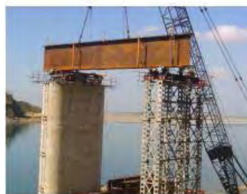
キリノ橋の上部工架設 (P-I)
