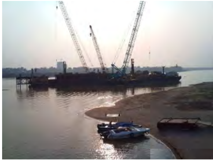
写真：ニャッタン橋の建設現場
