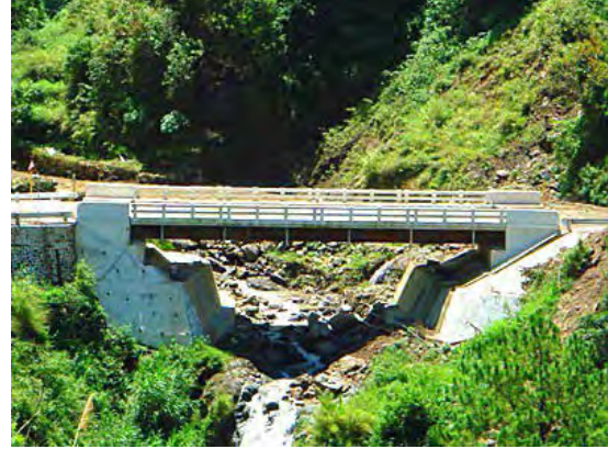
アムリメイ橋（組立式橋梁で支間は 35m 程 度までを可能としている）
