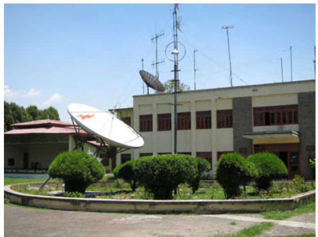
写真6. ラジオ・ネパール送出設備
