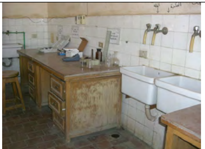
浄水場内水質検査室 (pH、濁度、残留塩素の3項目を検査)
