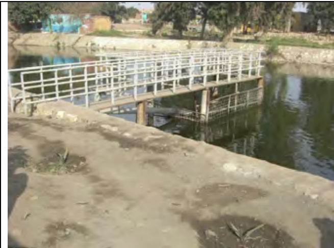
運河よりの取水口
