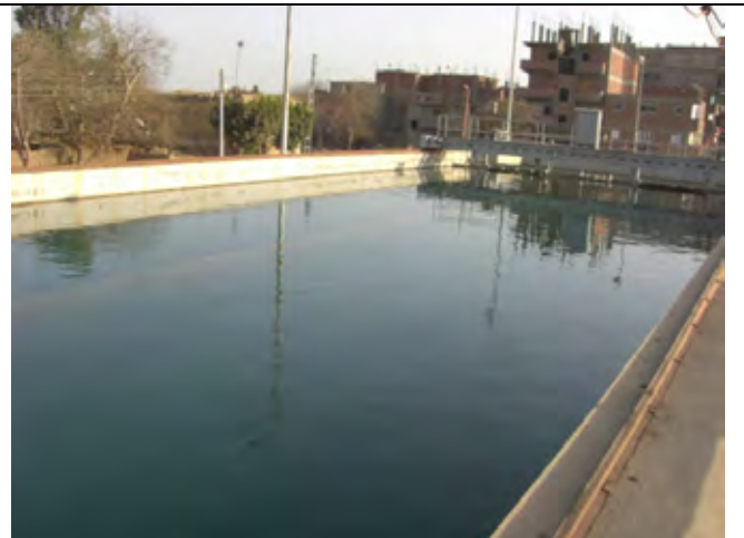
凝集・沈殿池
