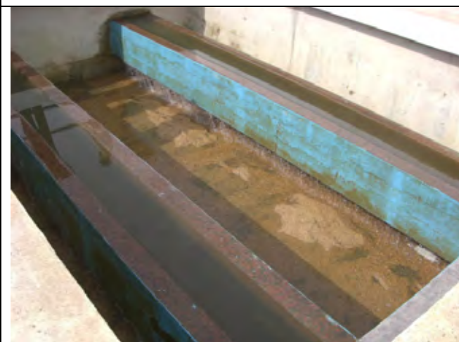
ろ過池(硫酸アルミニウムを投入した原水を沈殿池を経ずに直接ろ過する)
