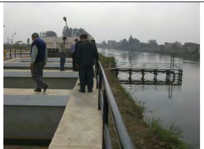
運河取水口とろ過池
