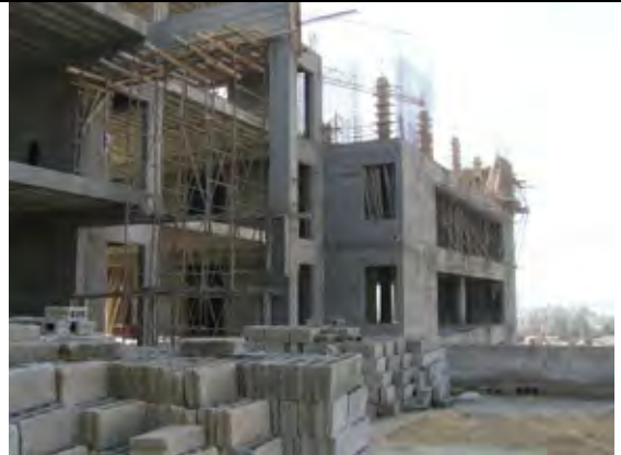
ラッカ小児専門病院 天井部分 2010年12月時点の工事状況
