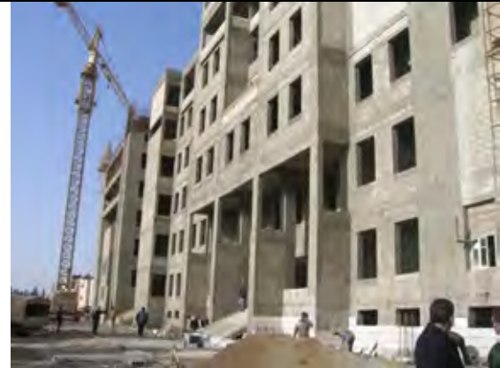
ラッカ小児専門病院 入り口 2010年12月時点の工事状況
