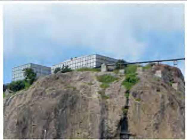
Soroti Municipality の給水システムの貯留タンク (Soroti 県) [2009 年 6 月]
