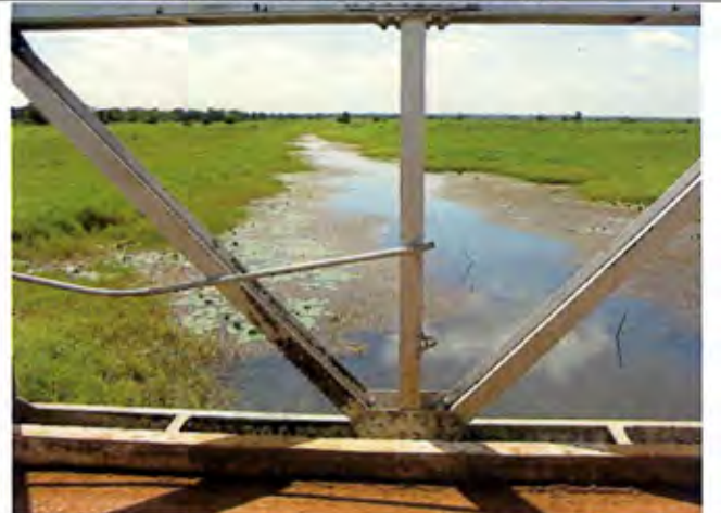
Katakwi の西方約 5km 地点での Okok 川。Okere、Okok 両流域の出口付近であるが、全く流れは殆ど無い。 (Katakwi 県) [2009 年 6 月]
