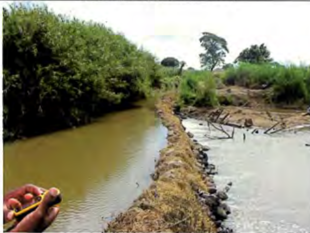
Mpolongoma 流域で、水田灌漑の水利権絡みの紛争の原因となっている簡易分水堰
