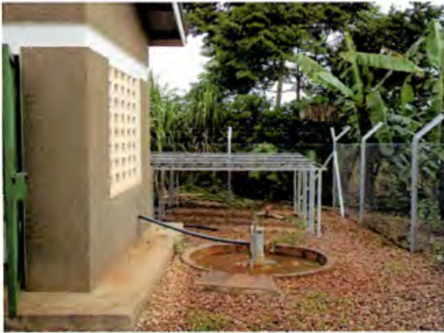
ソーラーを動力源とした給水システム (Nsozibili, Jinja 県) [2010年8月]
