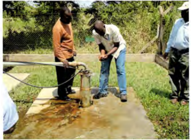
Soroti 県、Serere の給水システム。 (Soroti 県) [2010年8月]
