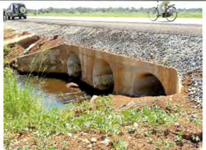
幹線道路に架かる簡易橋。洪水時には冠水してしまうことがある。
