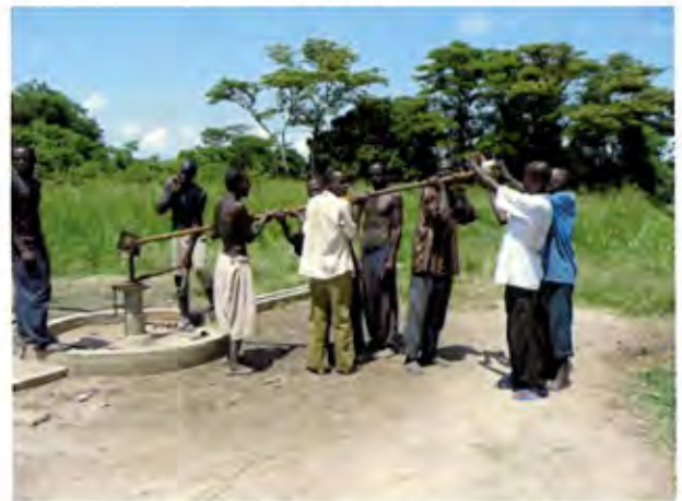
ハンドポンプ井戸の修繕作業中 (Soroti 県) [2009年7月]
