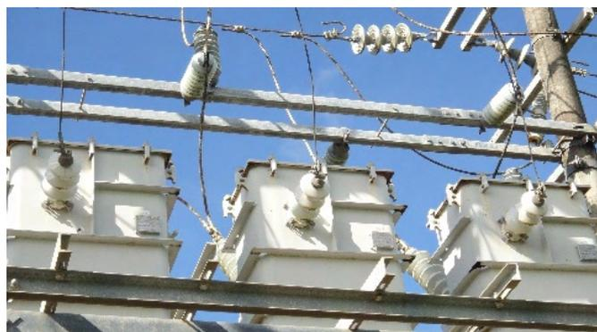
変圧器低圧側ブッシング欠け
