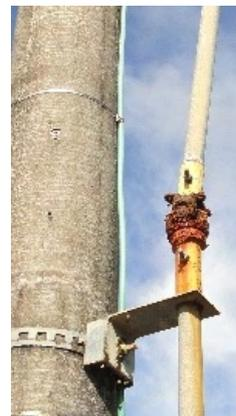
錆びた回転式断路器操作機構
