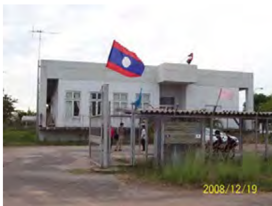
パワーハウス全景
