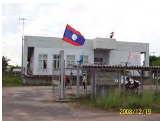
パワーハウス全景 空港内施設に電力を供給しているパワーハウス。PV システムを監視するモニター装置はこの建屋内に設置する。
