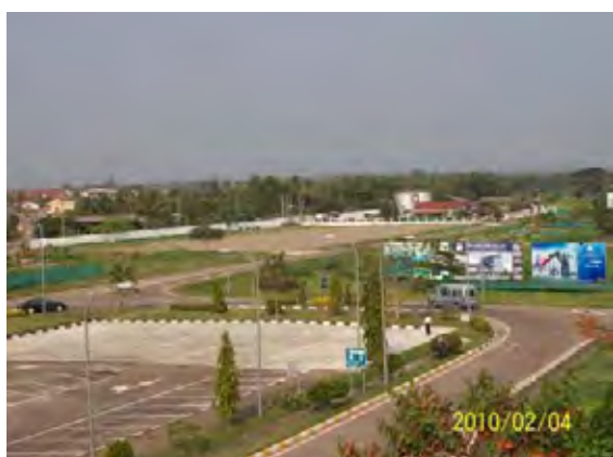
PV システム仮置き場予定地 写真奥の空き地が PV システムの仮置き場設置予定地。工事終了後、原形復帰する。
