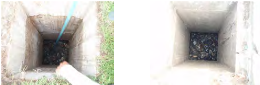
写真 R 3.2.7 王宮南側チャンバーの内に堆積した浮遊ゴミ
