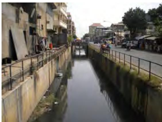
トラベックメイン排水路。ADB ローンにより補強・整備されて、2003年に完成した。本協力対象事業で整備する排水管の多くは、最終的にこの排水路に接続される。
