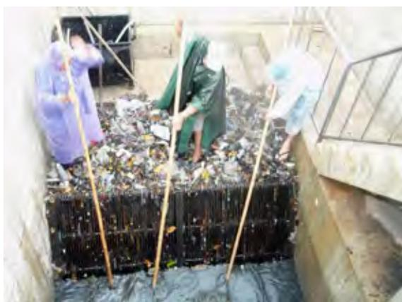
フェーズ2で建設されたスクリーンピット（雨天時）。道路等に廃棄された大量のゴミが排水施設を通じて排水ポンプ場に流入するため、詰まらせない様に除塵作業が実施される。
