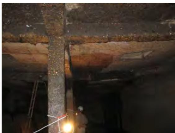
王宮南チャンバー内部の状況（2009年2月 清掃作業実施時に撮影）。天井がたわんでクラックが発生しており、各部材の強度低下が進行していることが明白な状態であり、早期の改修が必要な状態である。
