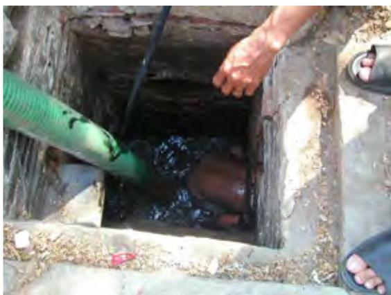
DSDによる排水施設の清掃作業。清掃機材の高圧洗浄機能が失われているため、洗浄ホースは給水に使用されるのみで、作業員が直接排水管に入って清掃を実施している。
