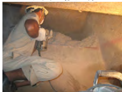
サイホン頂部堰毀し作業
