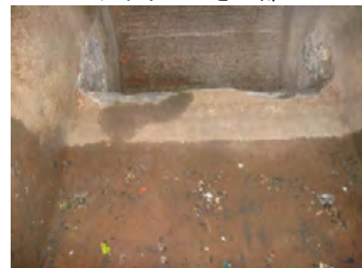
堰毀し作業完了後
