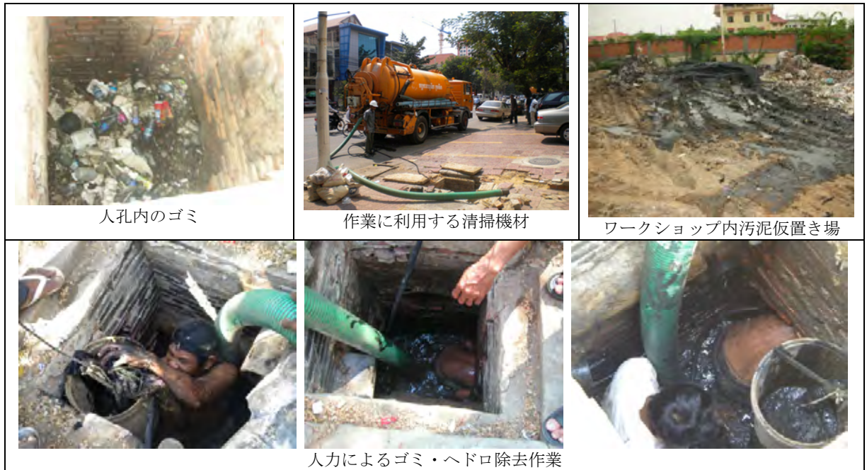
写真 R 2.1.6 DSD による下水管路清掃作業状況
