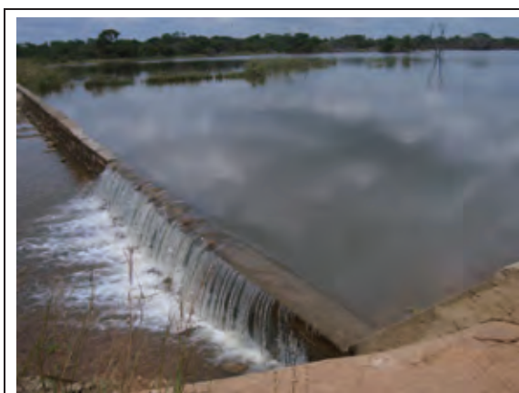
写真1：スキームの取水源のダム
